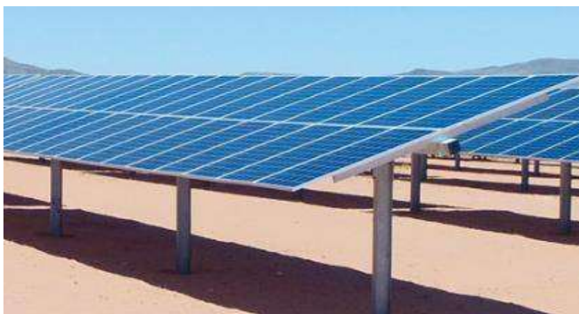
Ilustración 13 Configuración 2V de paneles FV.
