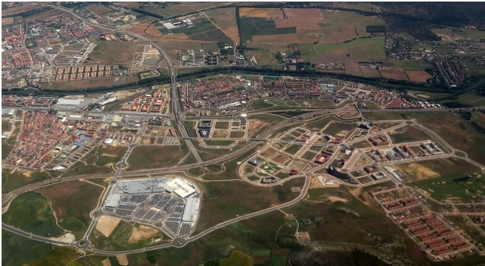
Figura 35. Vista del centro comercial Río Shopping, en Arroyo de la Encomienda. Fuente: Víctor Pérez Eguíluz, 2014.
