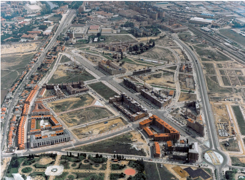
Figura 22. Vista de las obras de urbanización y construcción en los planes parciales de Parque Alameda (centro), Paula López (derecha) y Las Villas Norte (arriba a la izquierda). Fuente: AMVA, AM 8-15.
