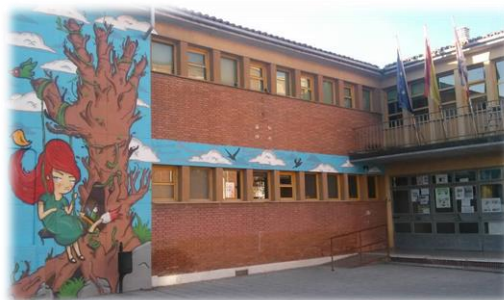
Fig. 10.: Fotografía de la puerta de entrada del CEIP Cristóbal Colón.
