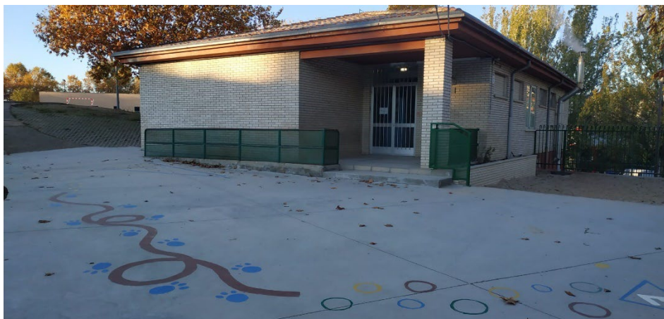
Figura 3: Edificio de infantil, tres años (Elaboración propia)
