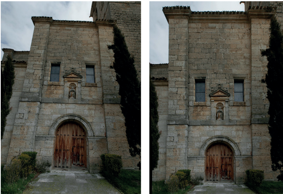
Figura 12. Rectificación fotográfica. A la izquierda imagen original y a la derecha imagen rectificada. Fuente: elaboración propia
