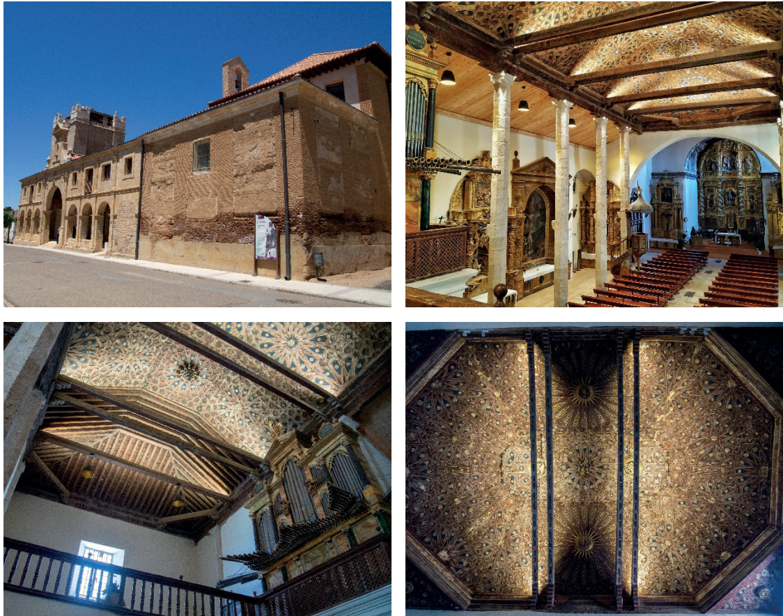
Figura 257. Fotografías del exterior e interior de la iglesia de Santa María. Fuente: elaboración propia
