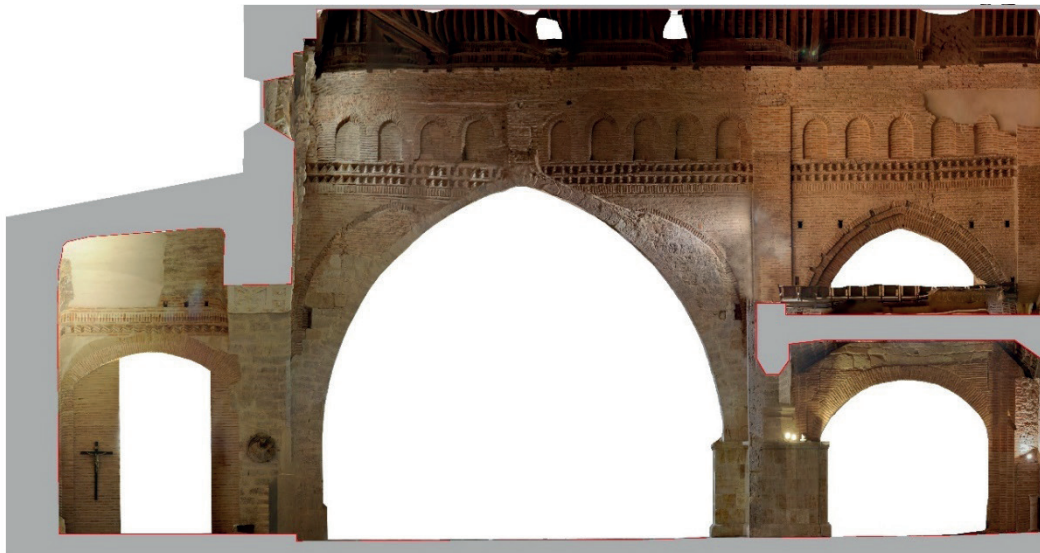
Figura 169. Ortofoto del estado actual del muro que separa la nave central de la nave de la epístola
