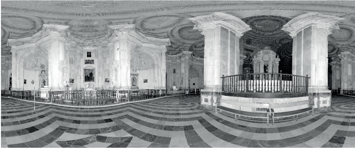
Figura 209. En las vistas planas de los escaneos se visualiza un efecto extraño a partir de la línea de cornisa interior. El problema fue debido a que a partir de ese punto había colocadas varias mallas, una de ellas de fibra de vidrio
