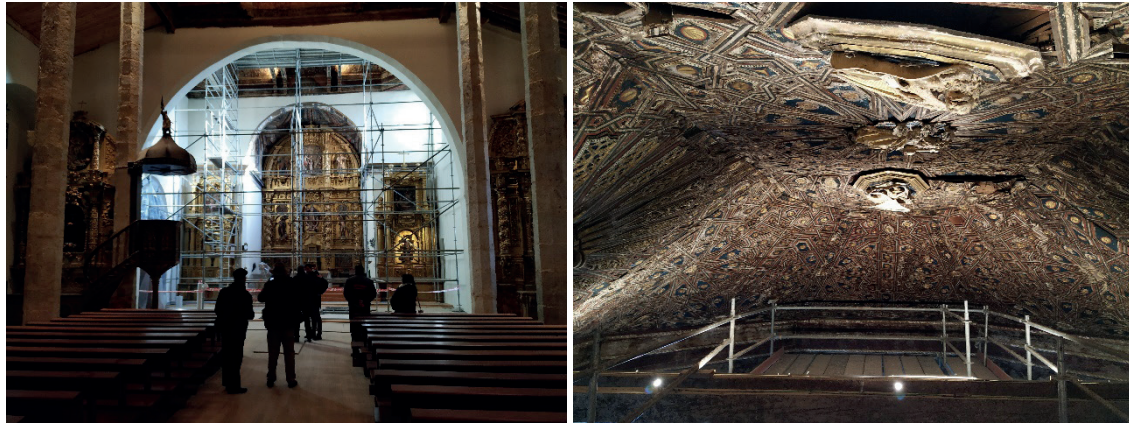
Figura 261. Andamio utilizado para la toma de datos y la restauración del artesanado. Fuente: elaboración propia
