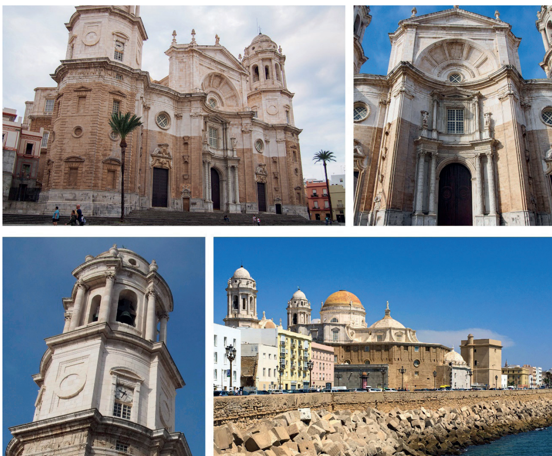
Figura 204. Fotografías del exterior de la catedral de Cádiz. Fuente: elaboración propia
