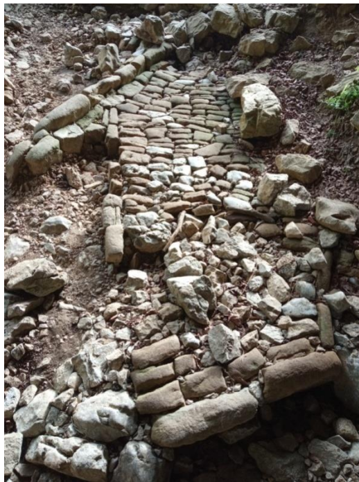
Lámina 12: Restos de la calzada en la salida oeste del túnel. (Fotografía del autor)
