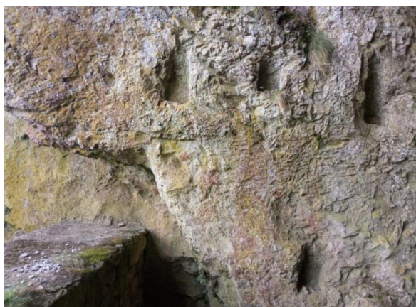
Lámina 9: Rebajes para apoyar las vigas. (Fotografía del autor)
