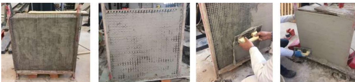
Figura 5. Proceso de ejecución de los refuerzos con TRM.
