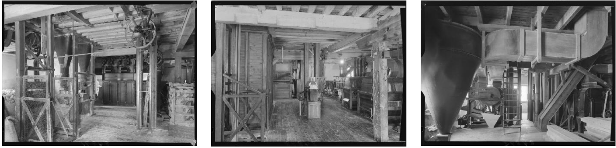
íbidem. De izquierda a derecha: sala de montacargas, poleas y saquerío, sala con cernedores, y sala de tolva con molino de fondo. Fuente: www.mcu.es/fototeca_patrimonio .
