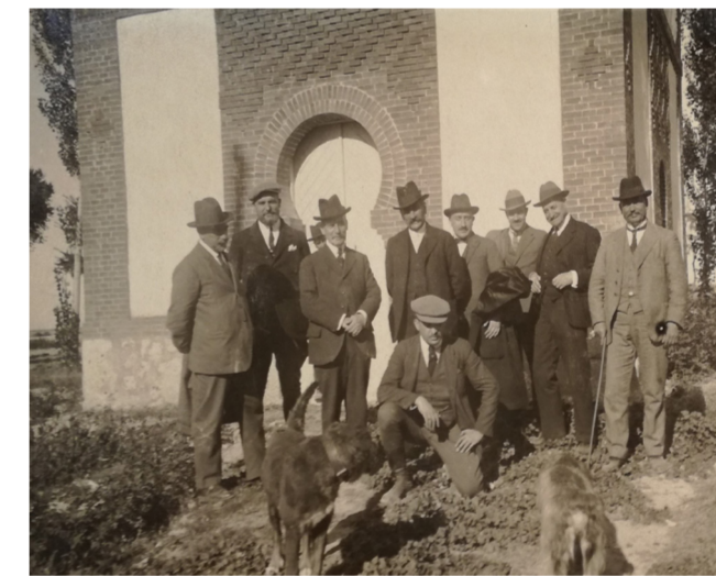
Fotografía de Emeterio Guerra y su grupo a los pies de la subestación eléctrica. 1926. Fuente: AHPV.
