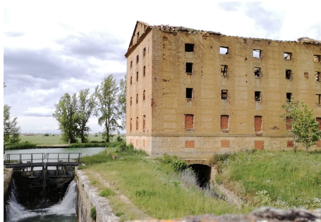
Fachada sur del conjunto fabril de la esclusa séptima del Ramal de Campos, con el cuerpo de fábrica, las compuertas de la esclusa y el paralelo canalizo. Fuente propia.
