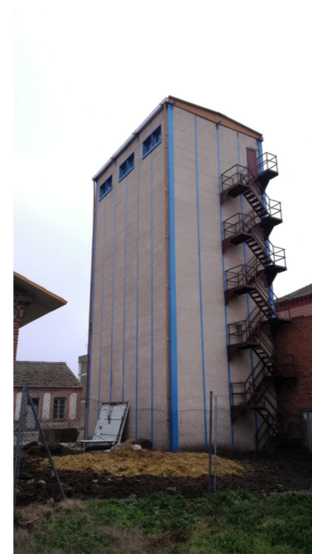
A la izquierda, silo de construcción moderna mediante sistema de hormigón y chapa, con sistema de escalera exterior metálica; derecha, depósito de aguas anexo a los restos de los viejos edificios harineros. Fuente propia.
