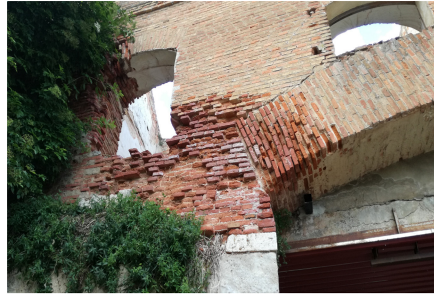
Fotografías de los paramentos oeste del cuerpo de fábrica, los cuales cuentan con un importante infiltración de humedades por capilaridad, en especial en el contacto entre la planta baja y primer nivel. El resultado es la pérdida de importantes secciones de morteros y desprendimientos de ladrillos de sus juntas. Fuente propia.
