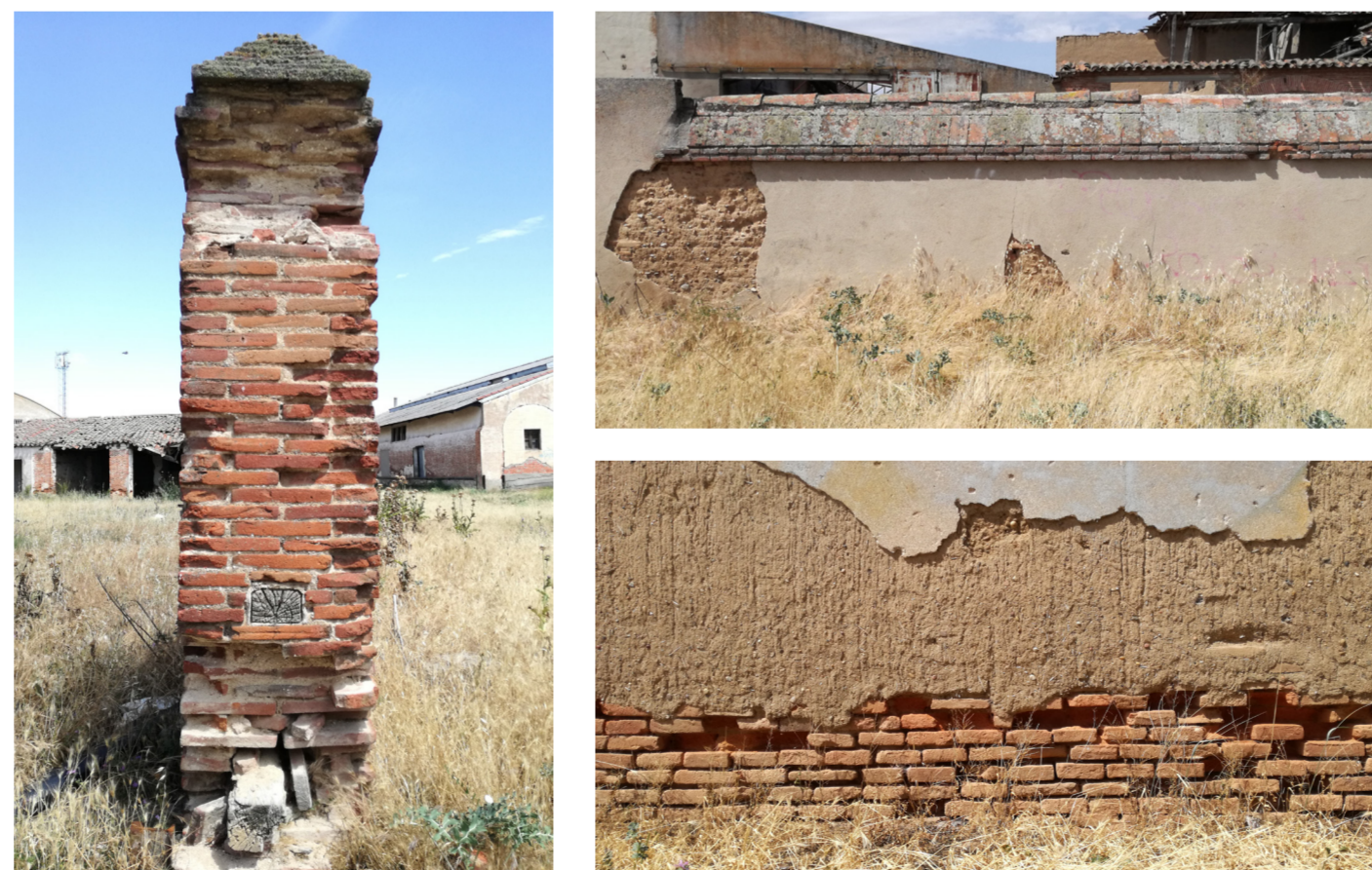
Diferentes puntos del muro de delimitación de la fábrica, mirando hacia la estación y vías férreas. Se aprecian tramos de ladrillo visto con vigas de madera de sujección, pero en general se dispone un paramento de ladrillo con sillarejo irregular, con un primer revoco de tierra y un segundo de mortero. Finalmente, para evitar erosiones de agua, se cubre el muro con ladrillo y teja. Fuente propia.
