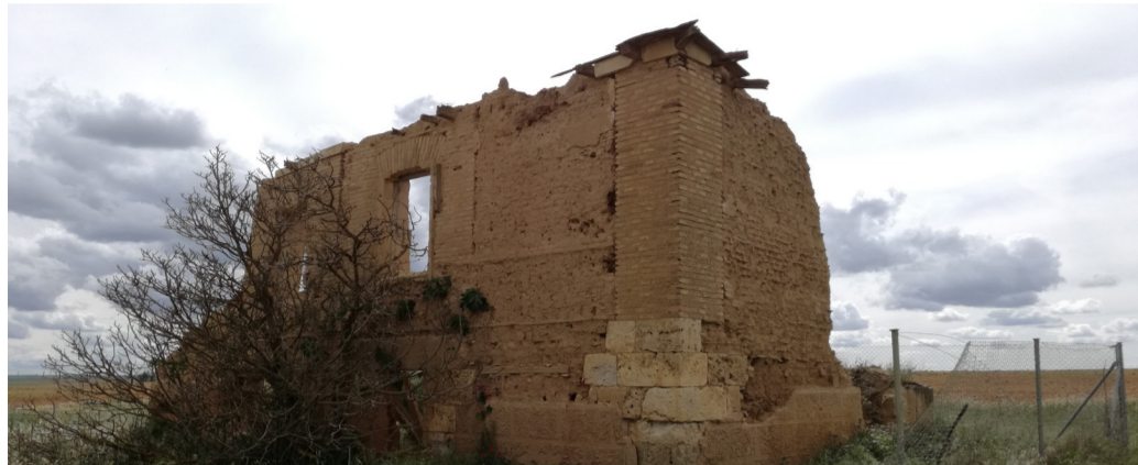
Restos de la casa del esclusero, al otro lado del salto del Canal, construido a base de mampostería, sillería, adobe y ladrillo. Fuente propia.
