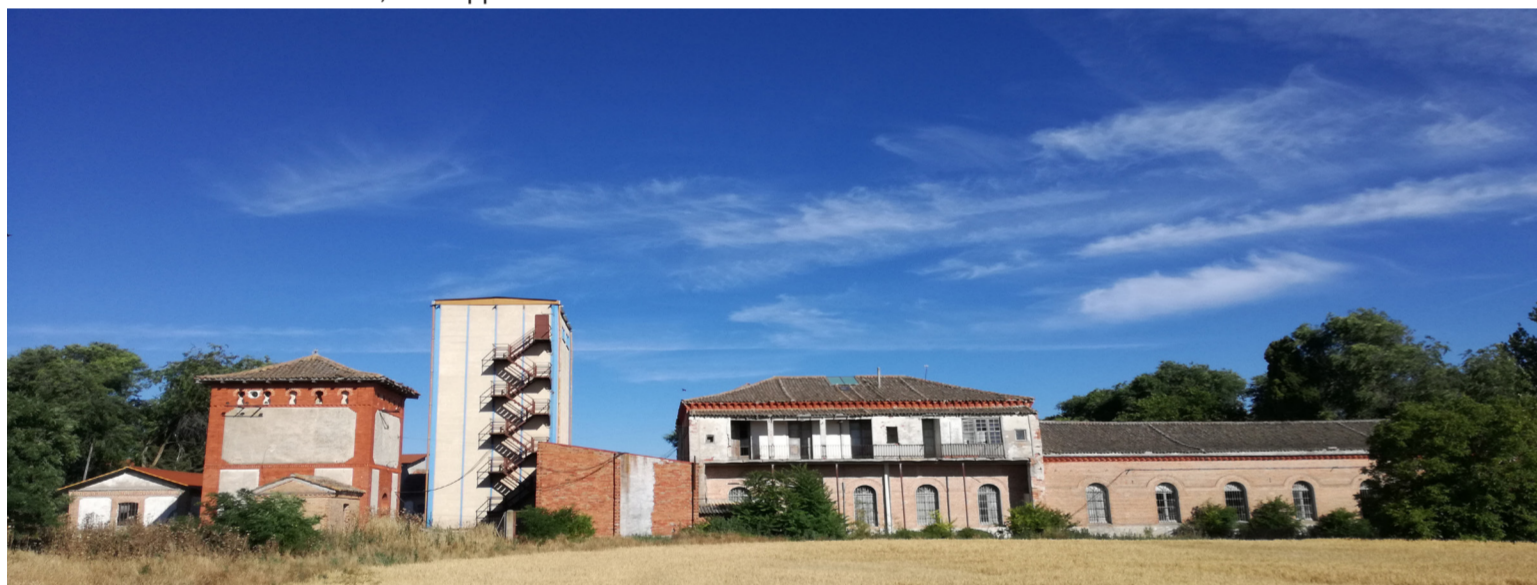
Perspectiva del conjunto visto desde el oeste: de izquierda a derecha: Torre de electricidad, silos, cuadras, viviendas, cocheras y almacenes. La torre del silo, rupturista, así como las cuadras, destacan sobre el resto, propio de esa parte del “feísmo” constructivo esporádico tan extendido en áreas rurales. Fuente propia.
