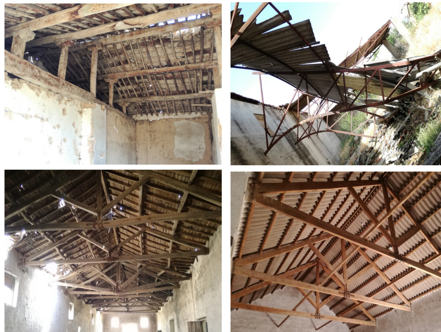
Imágenes de algunas de las techumbres del conjunto fabril de “La Navarresa”. En los casos superiores están los sistemas tradicionales de zapatas rústicas (almacén y cuadras exteriores) o sistemas de cerchas metálicas, hoy desplomadas; abajo, dos sistemas de cerchas a la española, uno original y otro contemporáneo, en cada uno de los almacenes anexos al cuerpo de fábrica. Fuente propia.
