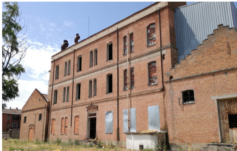
Fotografía del conjunto harinero de "La Navarresa" desde su fachada principal, hacia las vías de la estación. Fuente propia.
