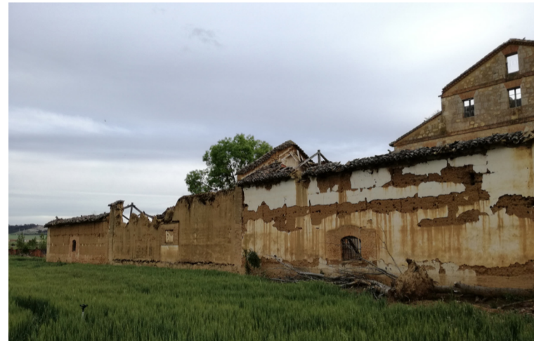
Perspectiva en esquina del cuerpo de fábrica, desde el noroeste. Se aprecia el desplome de las cubiertas, la quita de las carpinterías de vanos y su taponamiento a base de tejas y adobe. Con todo, la estructura guarda relativo buen estado. Fuente propia.
