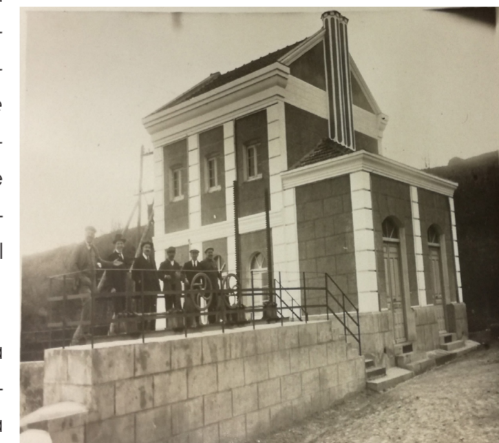
Edificio de la central hidroeléctrica sobre el salto del Adaja en Valdestillas, reteniendo en su interior la maquinaria de la época. Década de 1920.
