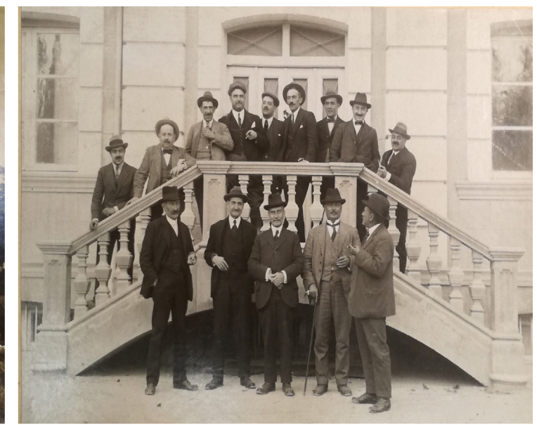
Fotografía histórica de la década de 1920, realizada en las escaleras de doble vertiente del cuerpo de fábrica, con las características molduras del paramento. Guerra Matesanz y compañía. Fuente: AHPV.
