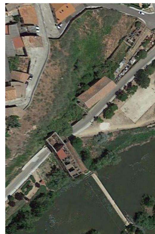
Imagen aérea con la situación de los tres cuerpos que conforman la fábrica de harinas de Simancas, en el centro el cuerpo de fábrica desmantelado de su techumbre, a la derecha el almacén de finales del XIX y a su derecha del último un volúmen en estado ruinoso.
