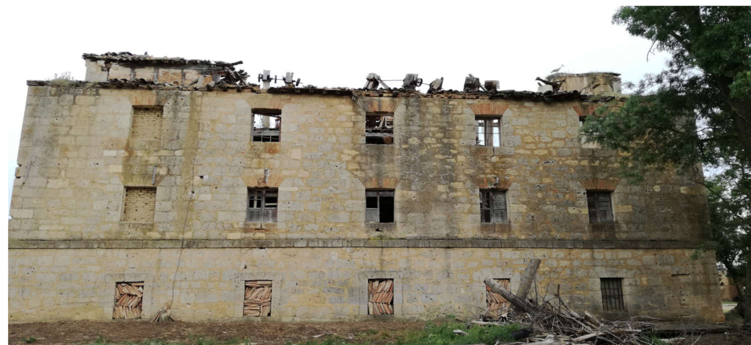
Imagen de la fachada trasera (oeste) del cuerpo de fábrica, en estado de abandono y degeneración. El bajo y los dos primeros pisos mantienen la fachada, mientras que el tercero y desván se han desplomado. Se aprecian salientes los mecanismos de ascenso de los trigos mediante poleas y engranajes. Por lo demás, resulta imposible adentrarse o simplemente apreciar algún mecanismo o estructura perteneciente al antiguo sistema de molturación, además de haberse recubierto el antiguo canal que discurría de forma paralela a esta cara de la fábrica. Fuente propia.
