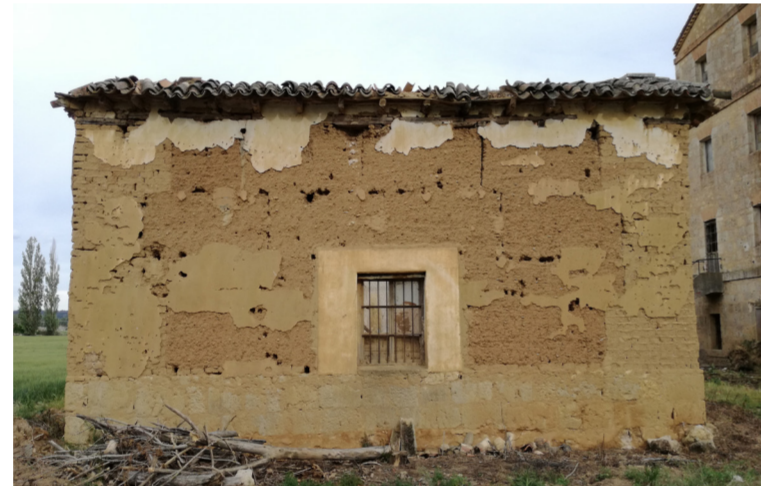
Perspectiva en esquina del cuerpo de fábrica, desde el noroeste. Se aprecia el desplome de las cubiertas, la quita de las carpinterías de vanos y su taponamiento a base de tejas y adobe. Con todo, la estructura guarda relativo buen estado. Fuente propia.
