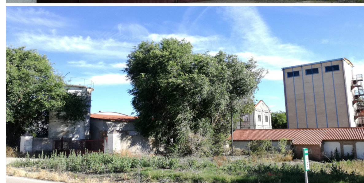
Diferentes perspectivas del conjunto desde el portón de entrada a la VA-303. Debido al impedimento de acceso, se ha visto limitado la comprensión de este caso de estudio. Las fotografías corresponden a los meses de enero (arriba) y junio (abajo) de 2021. Fotografía inferior: de izquierda a derecha: depósitos de agua, almacén, cuerpo de fábrica en ruinas, cuadras y silo. Fuente propia.
