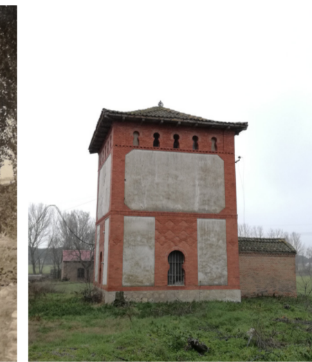
Torre eléctrica fotografiada desde la VA-303. Fuente propia.
