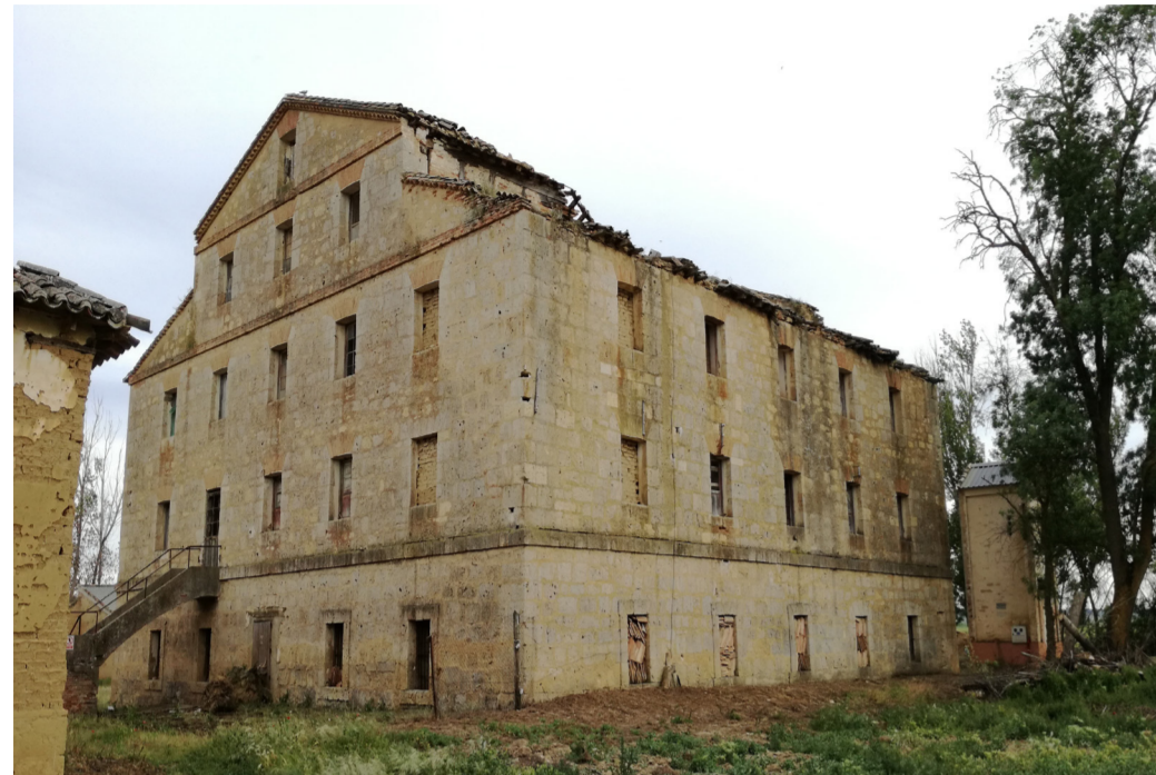
Perspectiva en esquina del cuerpo de fábrica, desde el noroeste. Se aprecia el desplome de las cubiertas, la quita de las carpinterías de vanos y su taponamiento a base de tejas y adobe. Con todo, la estructura guarda relativo buen estado. Fuente propia.
