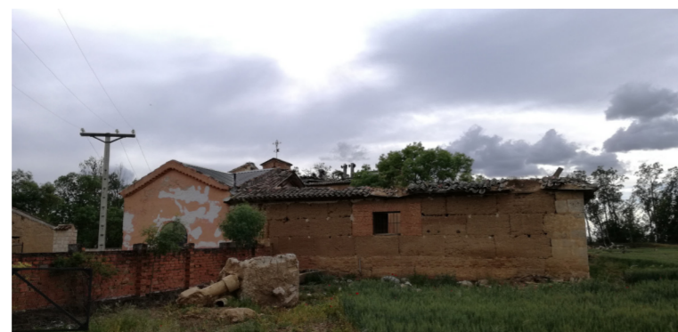
Fotografías relativas a las dependencias de la cara norte, construidas a base de mampostería, tapial y ladrillo, destinadas a almacenes y viviendas. A todas ellas se les ha desmantelado sus techumbres, aunque parcialmente se ha preservado los aleros, protegiendo en cierta medida los paramentos vulnerables. En el caso de la capilla, se ha revocado y pintado en tonos rosáceos, aunque la techumbre tradicional se ha sustituido por planchas metálicas, además de haberse perdido todo detalle de su fachada de acceso. Fuente propia.
