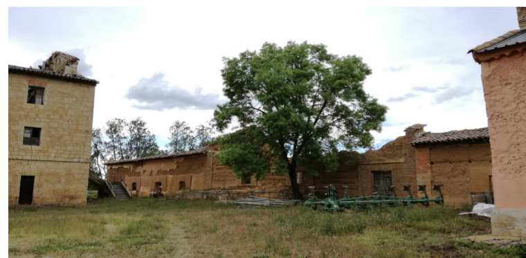
Fotografías relativas a las dependencias de la cara norte, construidas a base de mampostería, tapial y ladrillo, destinadas a almacenes y viviendas. A todas ellas se les ha desmantelado sus techumbres, aunque parcialmente se ha preservado los aleros, protegiendo en cierta medida los paramentos vulnerables. En el caso de la capilla, se ha revocado y pintado en tonos rosáceos, aunque la techumbre tradicional se ha sustituido por planchas metálicas, además de haberse perdido todo detalle de su fachada de acceso. Fuente propia.
