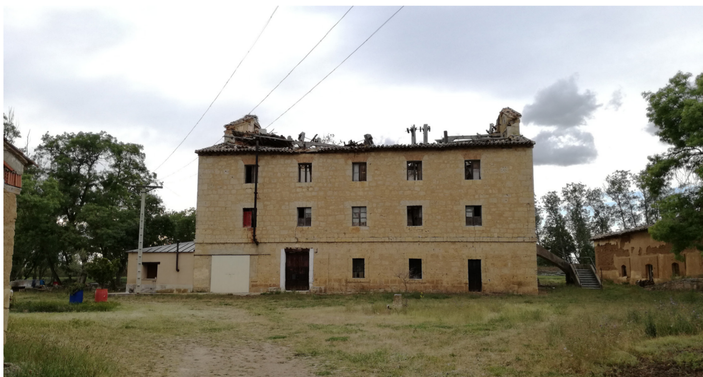
Imagen correspondiente a la fachada principal del cuerpo de fábrica, como se aprecia con los techos desplomados y los pisos parcialmente perdidos. Fuente propia.
