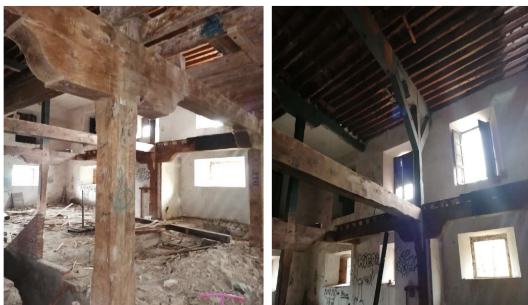
Sistema estructural de carpinterías del interior de una fábrica de harinas decimonónica. La fábrica es cercana en tiempo y espacio a la de estudio, no habiendo en este caso sustituido la estructura por las de fundición de finales del XIX. Es muy probable que, al menos la estructura más consistente, sea la original, cabiendo la posibilidad de permitirnos cierta superposición con como sería la de Tamariz de Campos antaño, durante su labor como harinera. Fuente propia.
