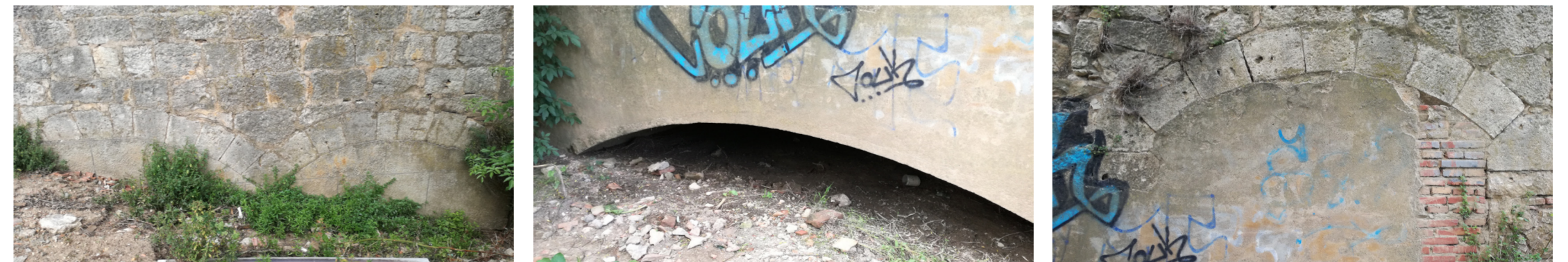
Fotografías correspondientes a los antiguos canales del cuerpo de fábrica, situadas en la fachada oeste del mismo. Son cuatro, dispuestas prácticamente como arquerías ciegas, debido a que se taparon hace ya décadas para impedir la filtración del agua en el edificio, una vez cerrado. Cuentan con importantes sillares, estando una de ellas reconstruida mediante mortero contemporáneo. Fuente propia.
