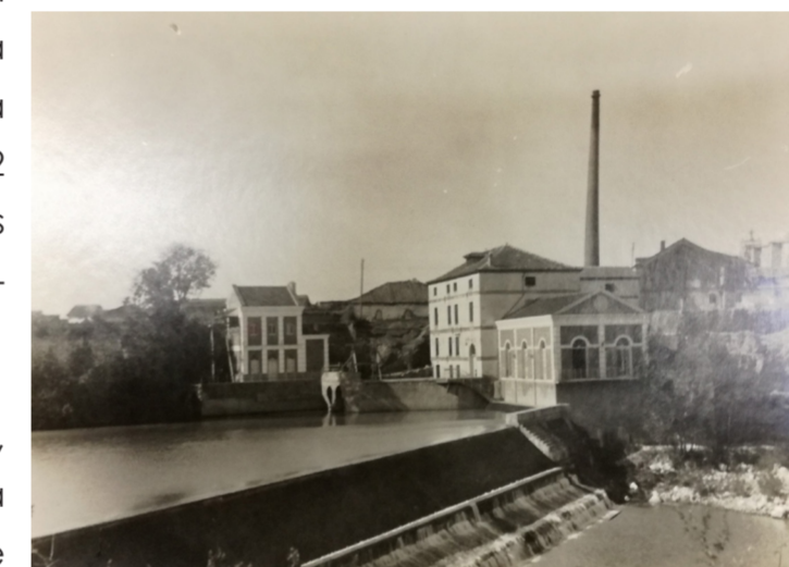
Fotografía histórica correspondiente a la fábrica hidroeléctrica de Valdestillas (Valladolid) en primer término junto al salto del Adaja. Detrás, la antigua harinera decimonónica de la localidad, desaparecida. Década de 1920.
