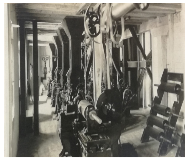
Fotografía histórica de los molinos de trituración, en la entreplanta baja, con rodillos de cilindros de repuesto a la derecha. Fuente: AHPV.
