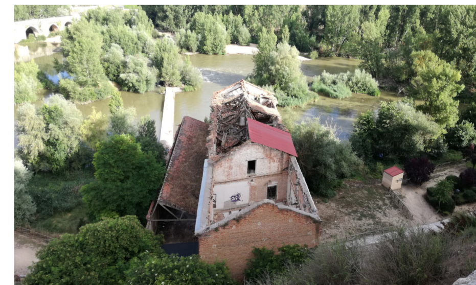
Fotografía del cuerpo de fábrica en estado de ruina. Se aprecia el dique contemporáneo y un volúmen añadido a mediados del siglo pasado a la izquierda. Las techumbres se han perdido o retirado, así como el entramado norte al completo. Con el tiempo, la sedimentación o los rellenos de asentamiento del firme han acabado por alejar la fábrica del cauce. Fuente propia.
