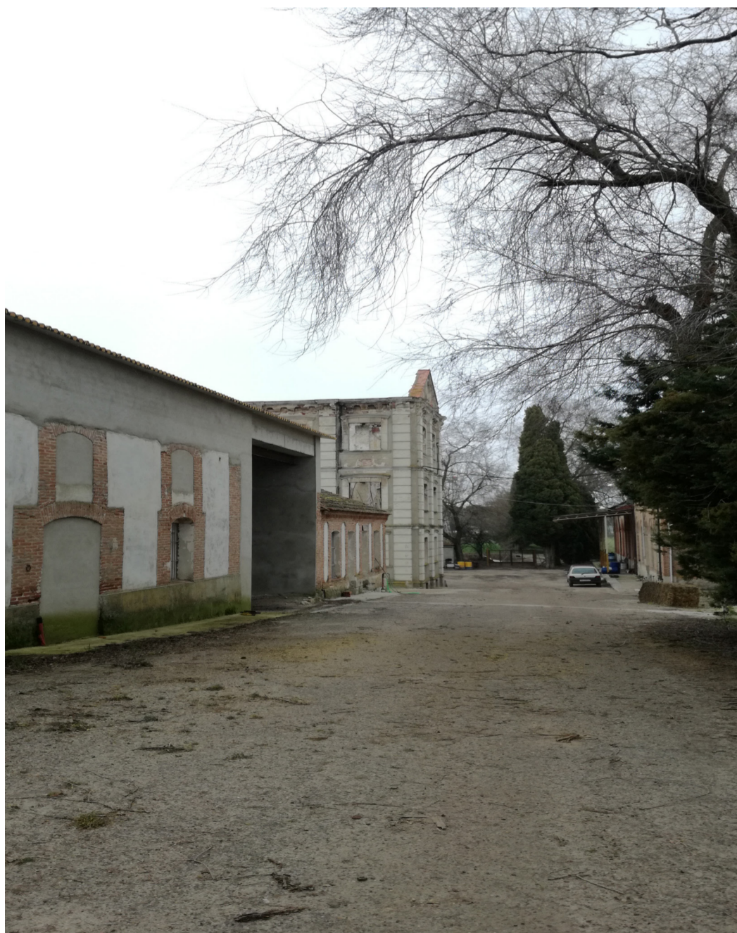
Fotografía realizada desde el portón de acceso del conjunto fabril de La Antoñita de Arrabal de Portillo. Se observa la superposición de fases constructivas, mediante añadidos materiales como hormigón, y el estado actual del cuerpo de fábrica, con las evidencias del incendio aún en sus muros. Fuente propia.
