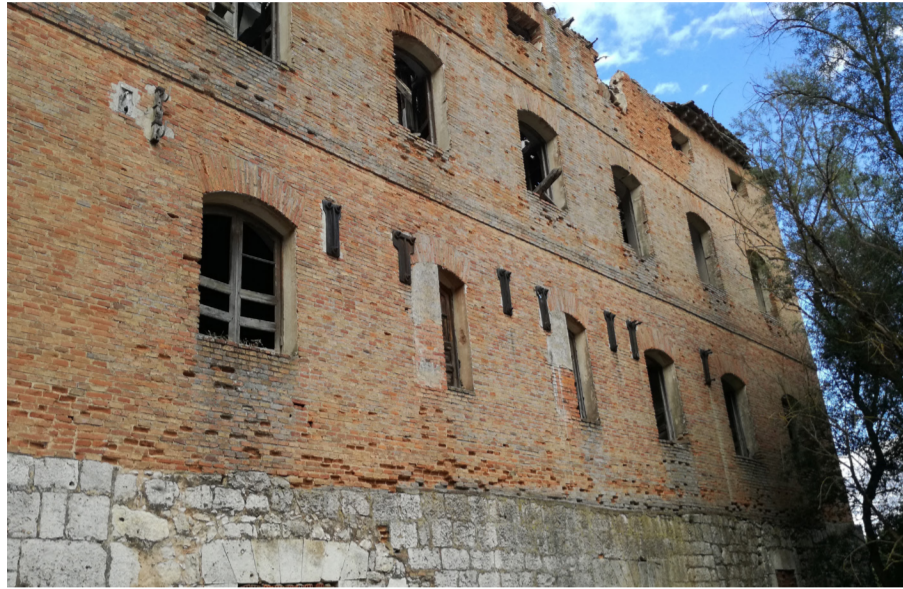
Fotografías de los paramentos oeste del cuerpo de fábrica, los cuales cuentan con un importante infiltración de humedades por capilaridad, en especial en el contacto entre la planta baja y primer nivel. El resultado es la pérdida de importantes secciones de morteros y desprendimientos de ladrillos de sus juntas. Fuente propia.
