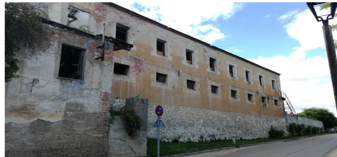
Almacén B, perspectiva completa de la fachada sur, hacia la vía pública. Su cara norte cuenta con fachada de cajones de adobe, sólo visible desde el Mirador. Fuente propia.
