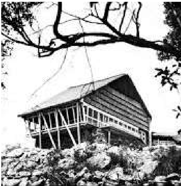
Ventorrillo de la Buena Vista el año de su construcción. (Fuente: Lucchini, 1970).
