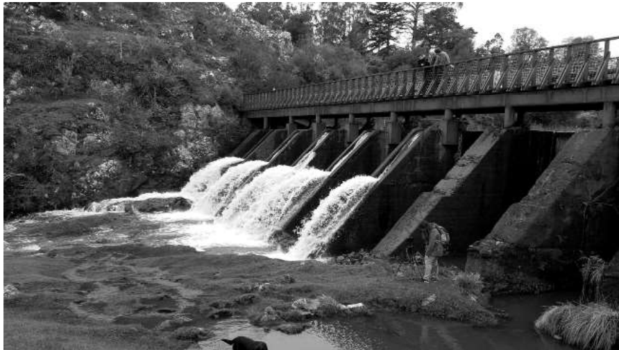
Represa Enrique Stewart construida en 1958 (imagenes actuales con agregado de pasarela peatonal y anexo de parque en Valle de la Alegria). (Web Villa Serrana SA).
