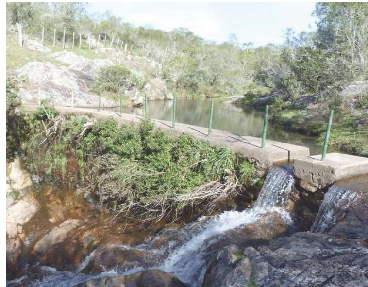
Arriba: Represa Enrique Stewart (1958), Villa Serrana. Debajo: Represa Baño de la India, Villa Serrana (imagen actual).
