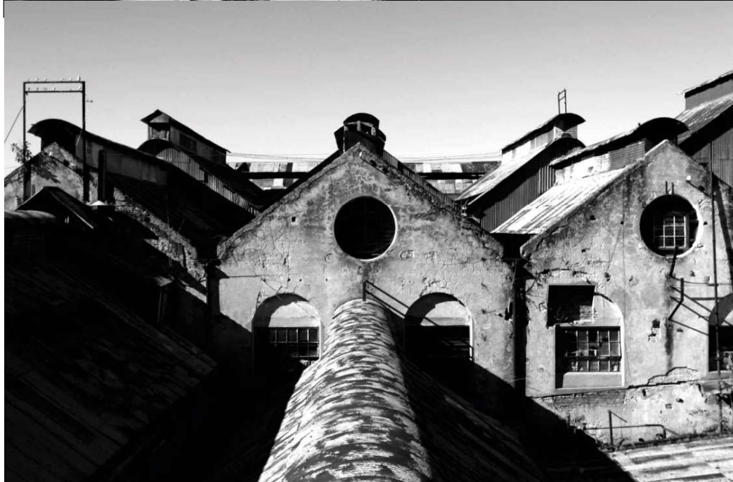
1. El frigorífico ANGLO en funcionamiento en 1925. 2. Las instalaciones abandonadas hoy declaradas Patrimonio mundial de la UNESCO. Fuente: (2010) Alonso, S. Craziun, M. de Souza, L. et al.
