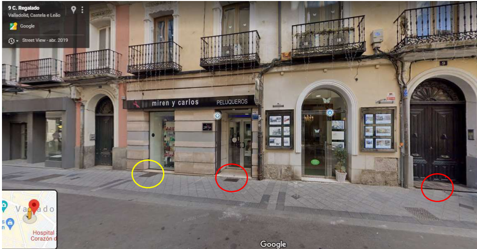
Figura 17 - Fachada del edificio de portales 9 y 7 de la calle de Regalado, demarcando los respiraderos de bodegas. Fuente: Google Street View, 2019. Modificado por la autora.
