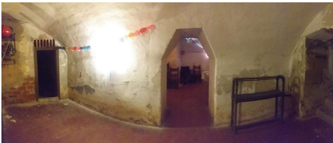
Figura 12 - vista en foto panorámica de la primera nave de la bodega hacia la puerta de acceso a la segunda nave. A la derecha se ve la escalera de acceso y a la izquierda la entrada para el cuarto del tanque de gasoil. Fuente: Producción propia.
