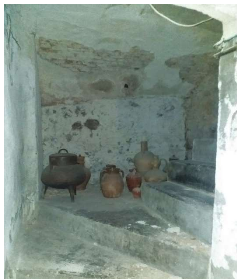
Figura 10 - Rincón trapezoidal en la escalera, con bóveda de ladrillo arriba. Fuente: Producción propia.
