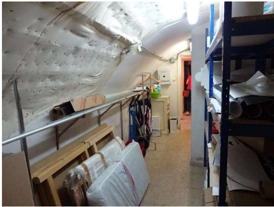
Figura 20 - Vista de la bodega de la zapatería Clarks desde el pie de la escalera hacia el fondo de la bodega, por el lado izquierdo del pilar y de las baldas del almacén. Fuente: Jové, Félix (2021)
