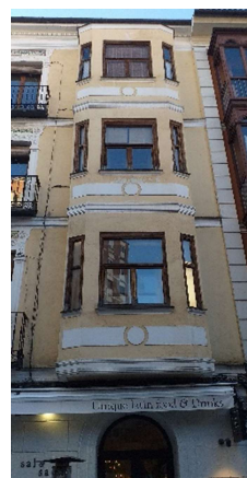
Figura 7 - Mirador reformado. Fuente: Producción Propia
