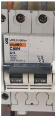
Ilustración 10. Interruptor automático magnetotérmico.
