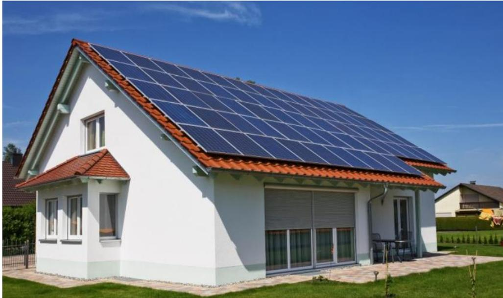
Ilustración 22. Instalación fotovoltaica de autoconsumo. Fuente:[23]
