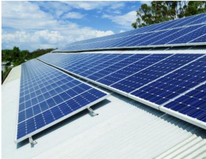
Ilustración 113. Cubiertas compuestas por chapa con técnica rosca chapa. Fuente: [49]
