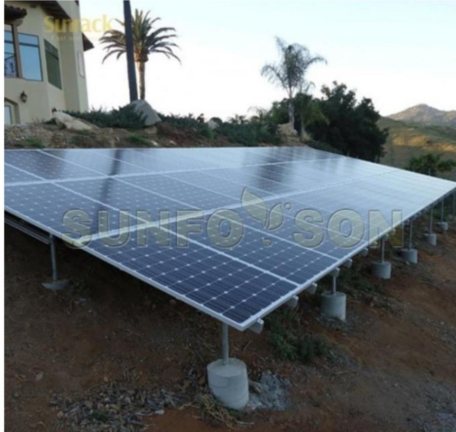
Ilustración 114. Estructura metálica con base de hormigón.
