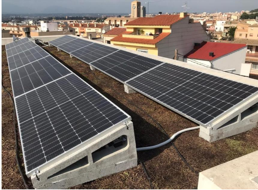
Ilustración 115. Estructura de hormigón. Fuente:
