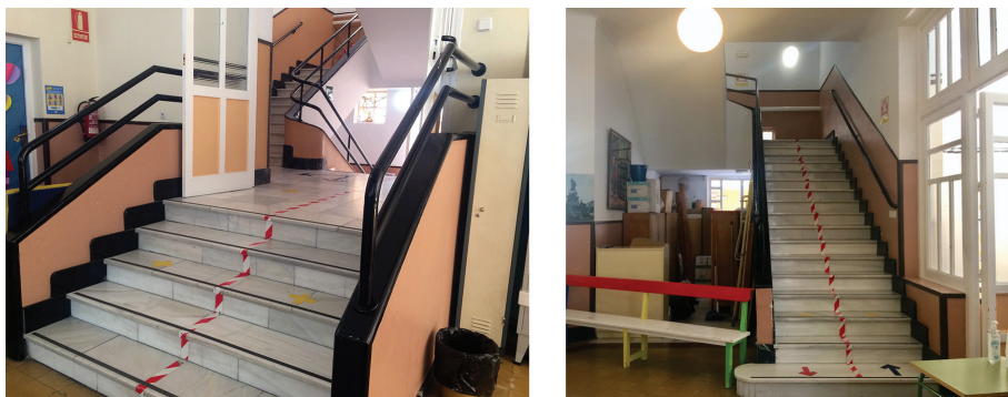
Fig. 9. Detalle de nuevas escaleras para conexión de pasillos y niveles en el CEIP San Fernando (Fuente: Fotografías del autor).
