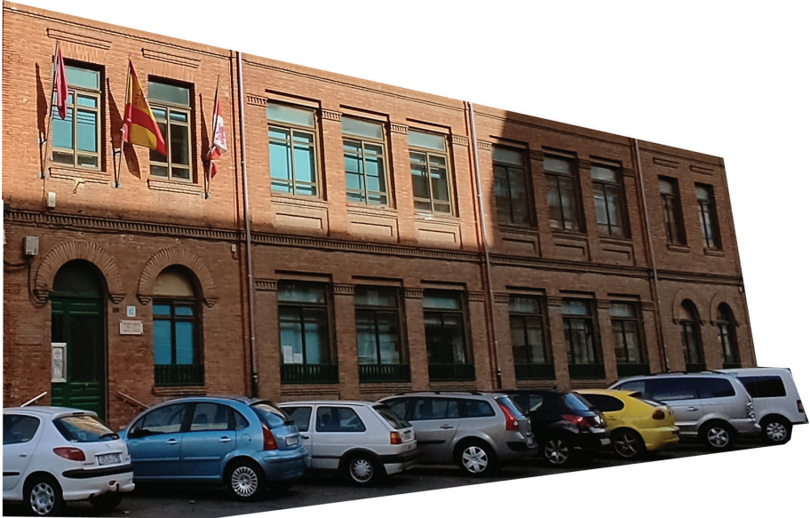
Fig. 15. Imagen de los dos cuerpos de la fachada principal del actual colegio público Macías Picavea, en la calle Madre de Dios, proyectados en origen por Juan Agapito y Revilla (Fuente: Elaboración propia del autor).
