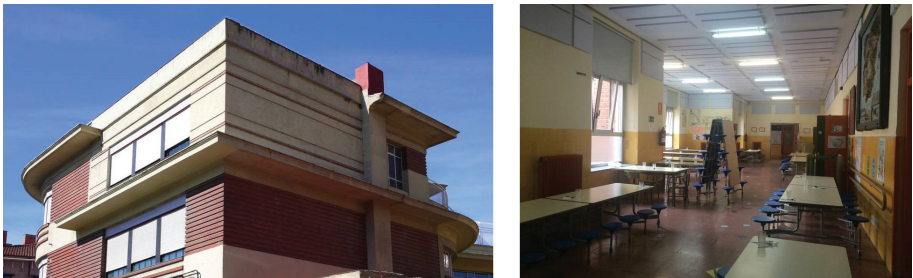
Fig. 15. “Ocupaciones” insólitas de edificios escolares en Valladolid: arriba, ampliación de un aula en la terraza del CEIP San Fernando; abajo, implantación del comedor escolar en el pasillo-galería del CEIP Antonio García Quintana, antigua Escuela Normal (Fuente: Fotografías del autor).
