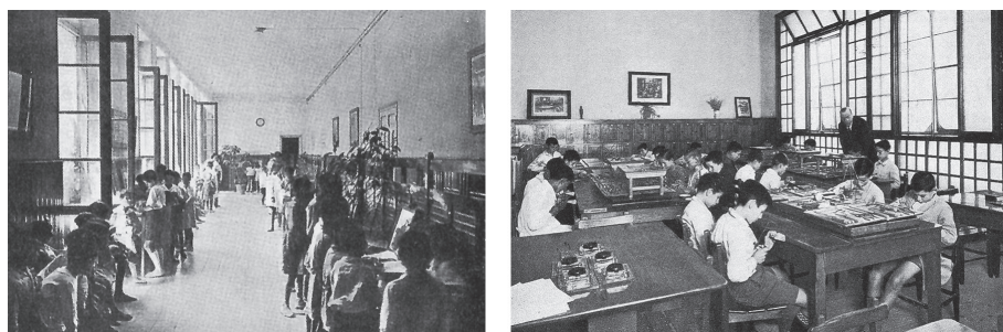
Fig. 9. Fotografías de época de la galería (izquierda) y aula-taller (derecha) de la escuela Cervantes, destacando la ventilación e iluminación natural de sus ventanas abiertas de par en par (Fuente: Guerrero, 2002: 106 y 103).
