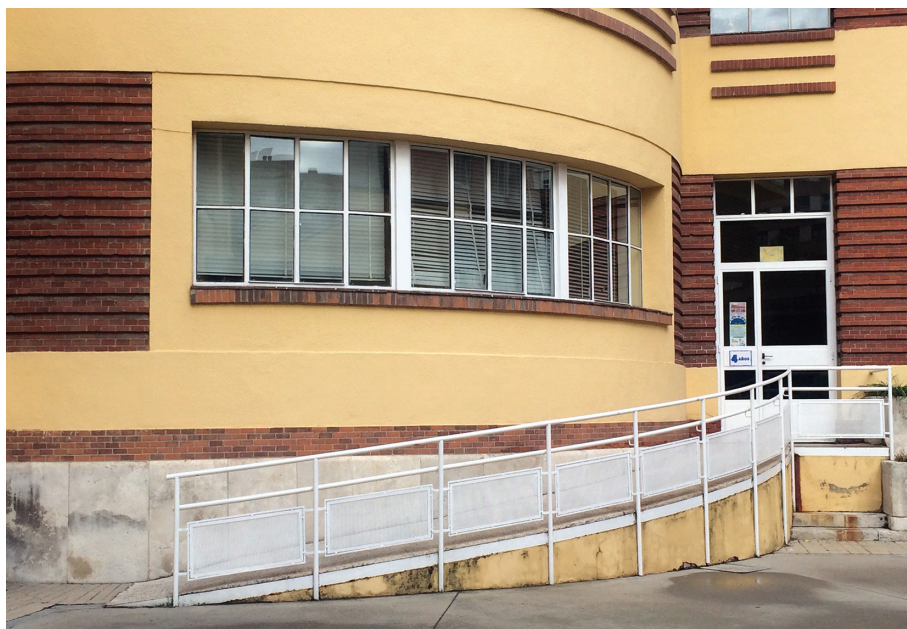
Fig. 11. Nueva rampa de acceso desde el patio de juegos para resolver problemas de accesibilidad y supresión de barreras arquitectónicas en el CEIP San Fernando de Valladolid (Fuente: Fotografía del autor).
