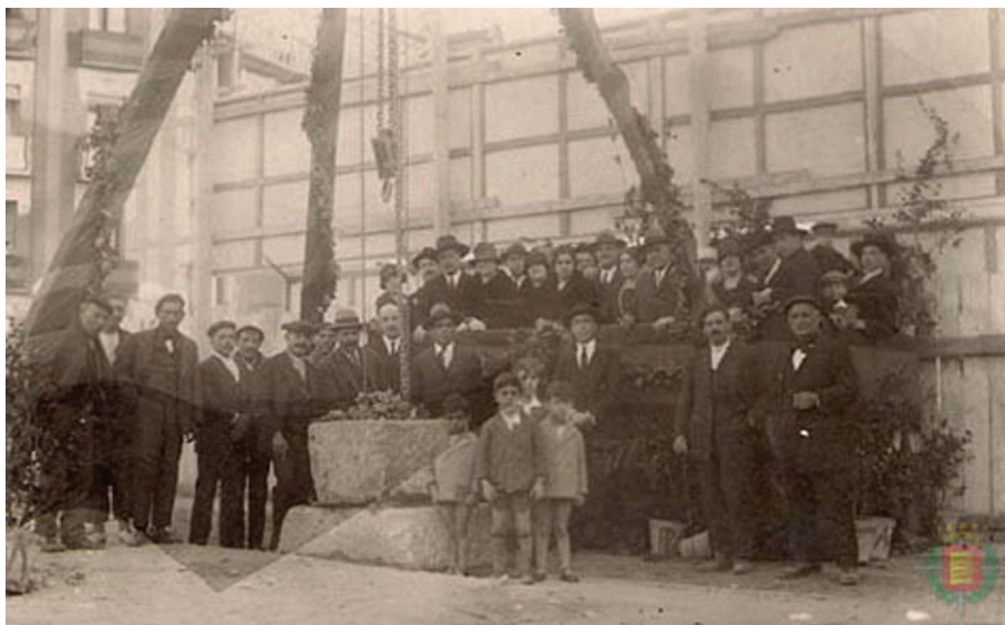
Fig. 8. Fotografía del acto de colocación de la primera piedra de las escuelas normales, celebrado el 27 de marzo de 1927 (Fuente: Archivo Municipal de Valladolid (AMVA), COL 1689).
