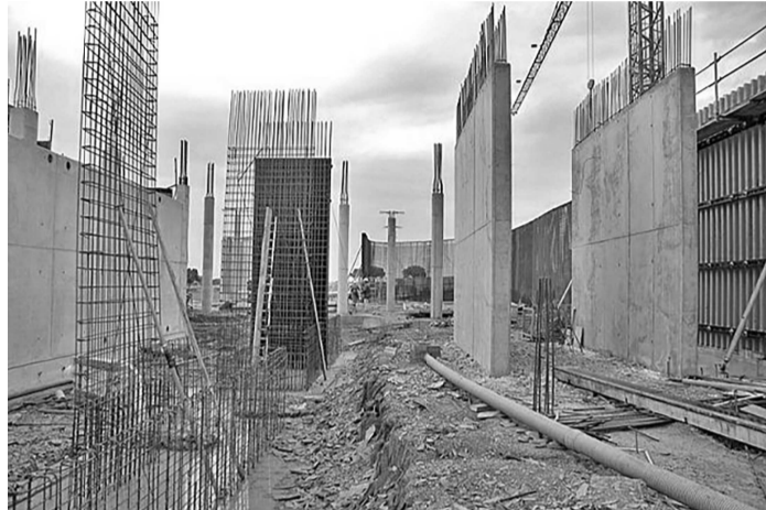
Cimentación. Vista de ejecución
