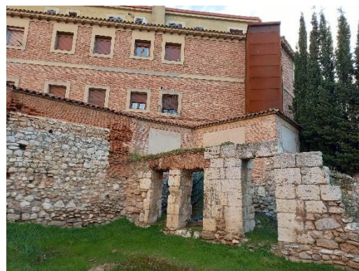
3. Muros de separación con el Viejo Coso
