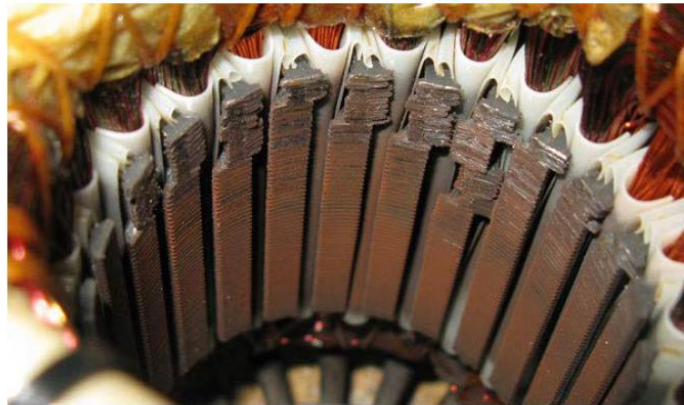
Figura 4.20. Deterioro de las chapas del estátor por excentricidad. [14]
