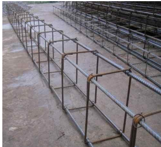
Ilustración 7 : Barras de acero corrugado soldadas para reforzar una viga. Fuente [14]
