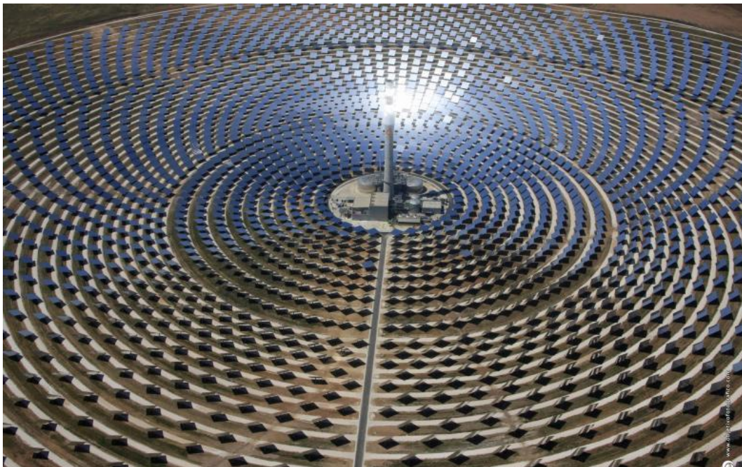
Figura 3.8: Planta solar térmica Gemasolar, Fuentes de Andalucía, España.
