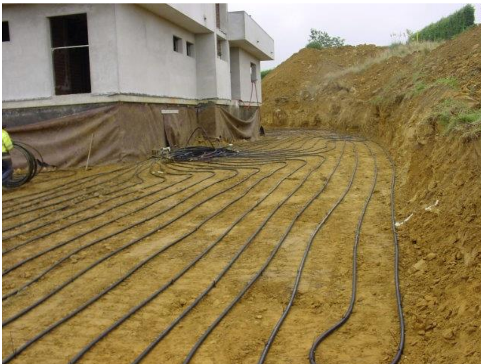
Figura 3.5: Geotermia con captación horizontal.
