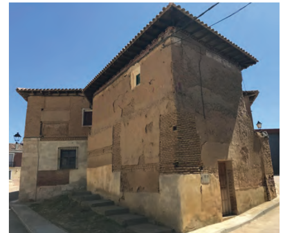
Construcción tradicional: piedra, tapial y adobe, Paredes de Nava.
