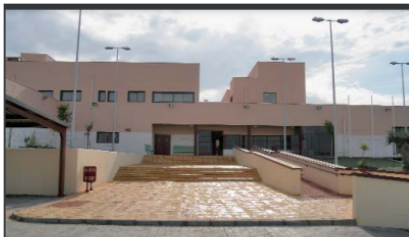
Figura 2. Fachada principal de la Unidad de Madres perteneciente al Centro de Reinserción Social de Sevilla.
