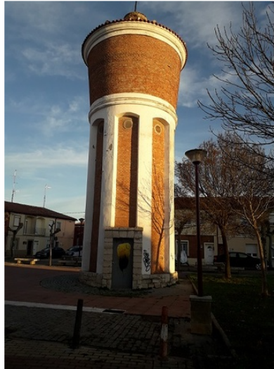
Depósito de agua de San Pedro Regalado
