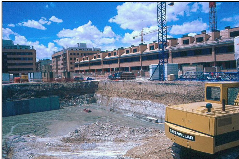
Parque Residencial Carcavilla en fase de ejecución. 2000
