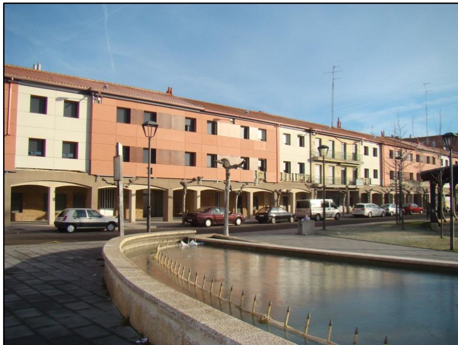
El Grupo 1691, durante las obras de rehabilitación del ARI. 2008
