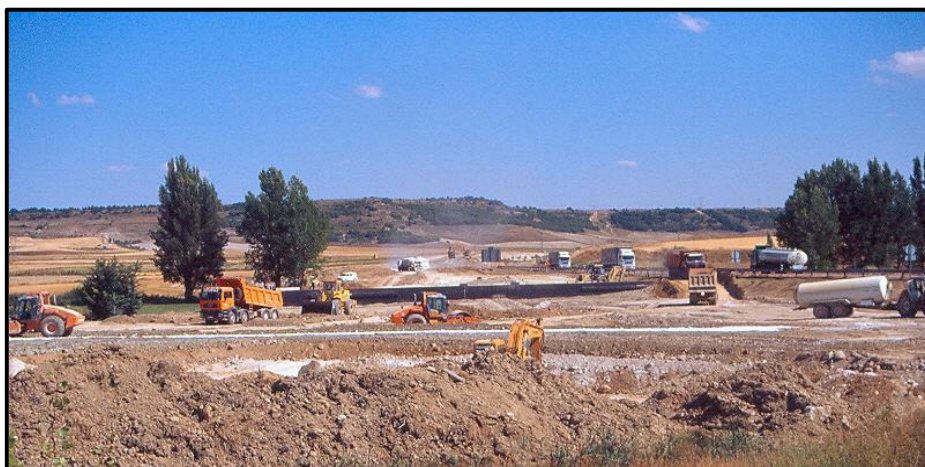
Obras de desdoblamiento en la A-65. julio 2003
