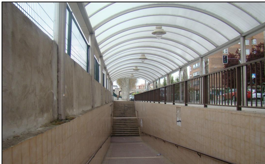
Paseo subterráneo de Alfonso X a Reyes Católicos. Marquesina
