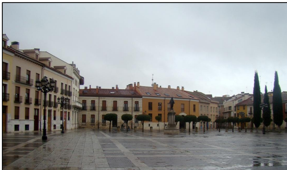
Plaza de la Inmaculada. Rehabilitación ambiental.
