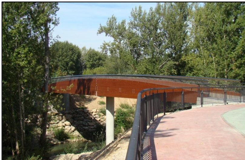
Pasarela entre la zona deportiva del Parque dos Aguas y la Lanera
