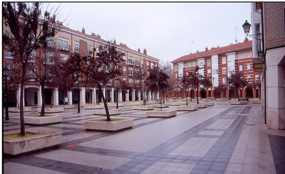
Plaza de los Dominicos. Una vez concluido el Plan Especial de Reforma Interior
