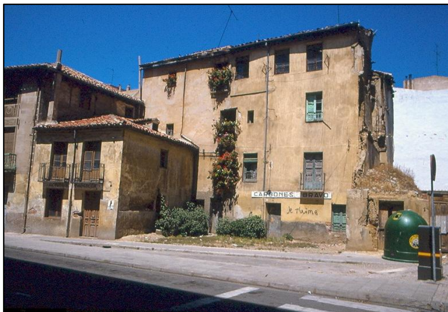
Uno de los últimos edificios de viejo arrabal de La Puebla antes de su desaparición. Calle Cirilo Tejerina. 1987
