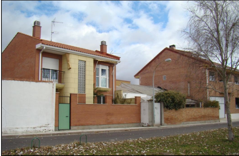
Nuevas viviendas unifamiliares con dos alturas. Calle Virgen del Brezo. 2008
