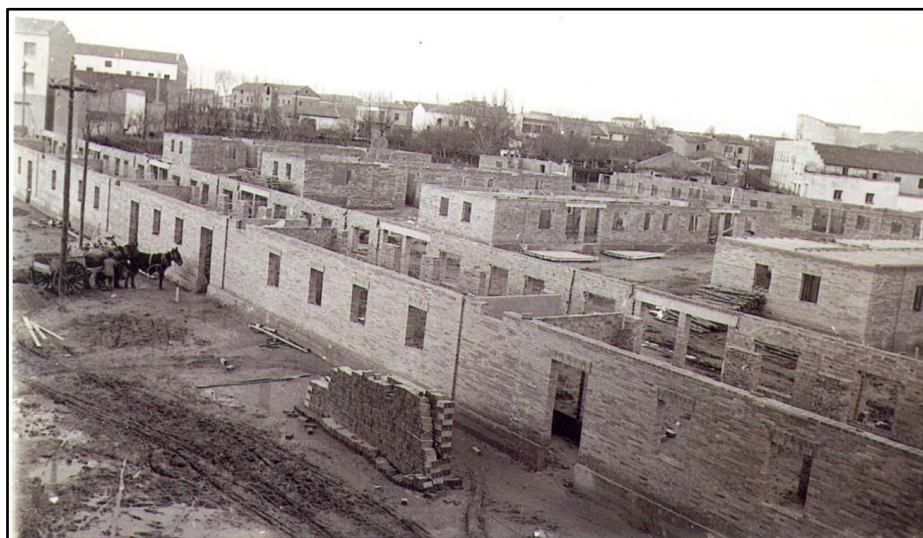
Obras de construcción del Grupo 205 de la barriada Francisco Franco de Palencia. Enero de 1955. Fotografía del Expediente.
