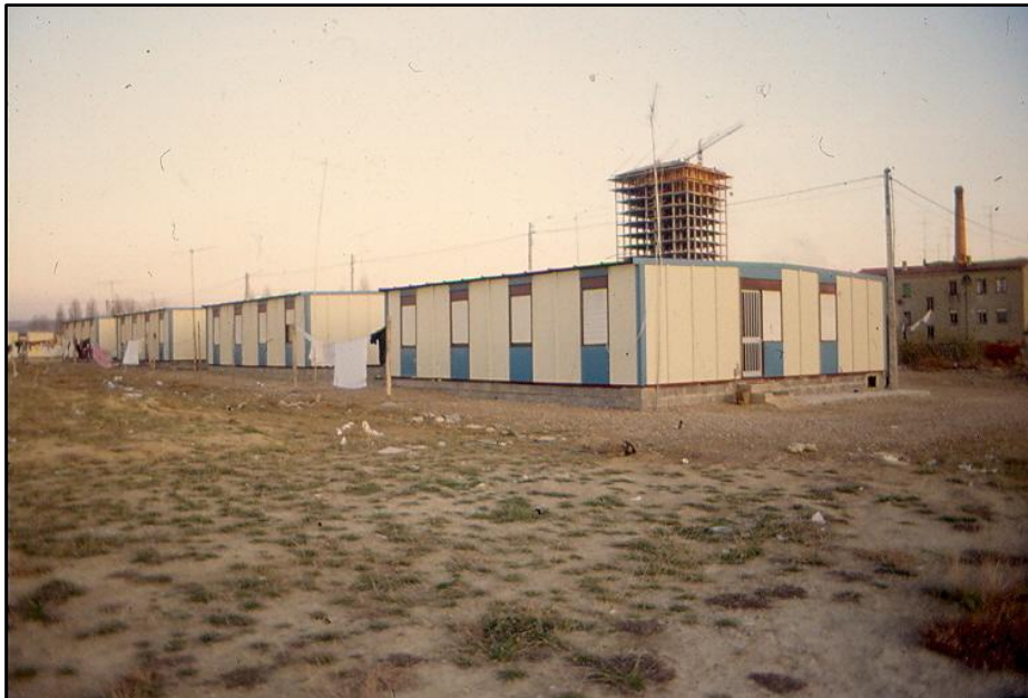
Barracones de Laguna Salsa en 1980. Al fondo torre del Polígono de Pan y Guindas en construcción.
