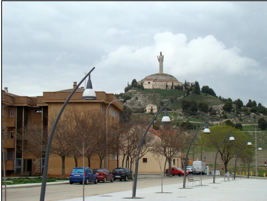
Alumbrado del nuevo Parque del Barredo Viejo, ejecutado con cargo al URBAN
