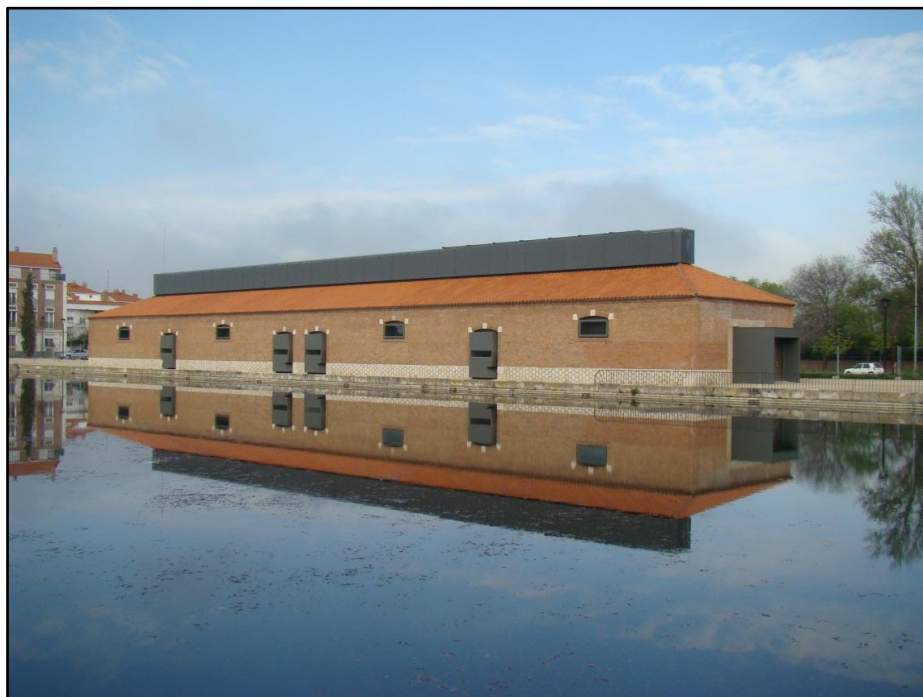
Almacén de la dársena rehabilitado para Museo del Agua. 2010
