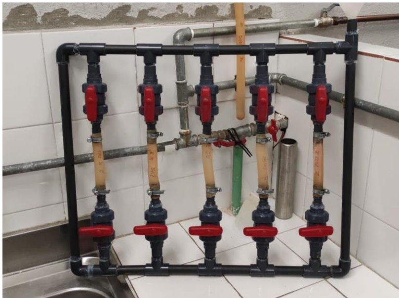
Figura 9 Almacenamiento de tubos de látex. Nótese en el fondo un tubo largo recién fabricado y colgado, aún sin cortar.
