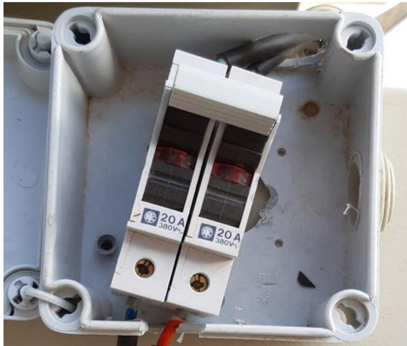
*Figura 46: Elementos de protección y seguridad para las conexiones de los transductores de tensión. Fuente: Fundación CARTIF*
