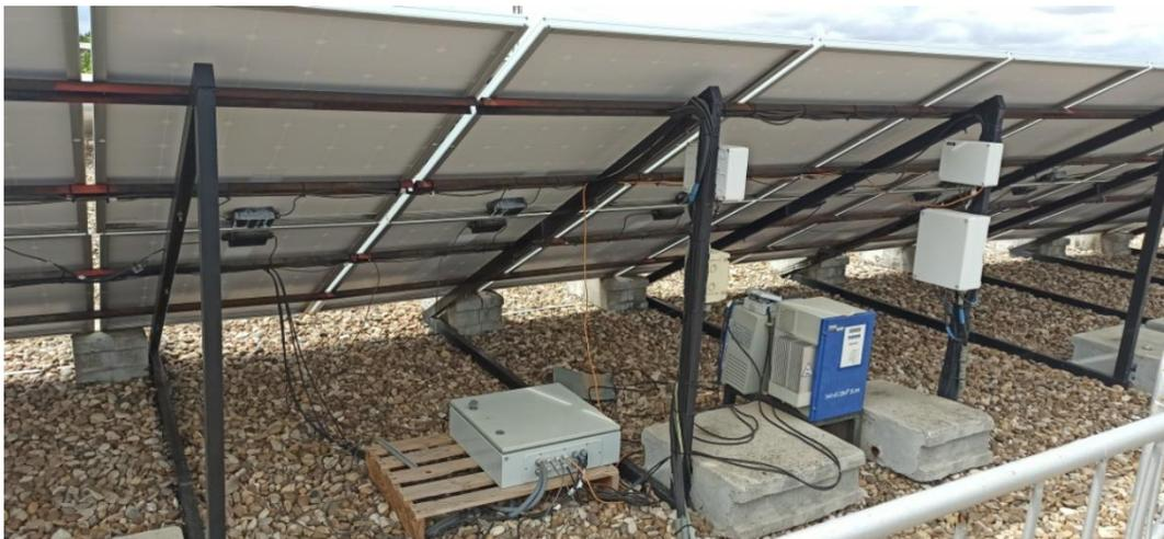
Figura 16: Elementos de la instalación y conexiones entre ellos. Fuente: Fundación CARTIF
