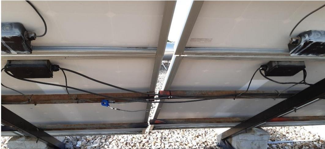
Figura 43: Conexión VS1 y VS2 en las filas de nueve paneles. Fuente: Fundación CARTIF
