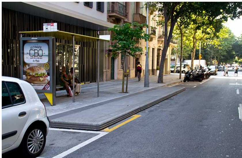
Fig 26. Uso de plataforma para ampliar la acera
