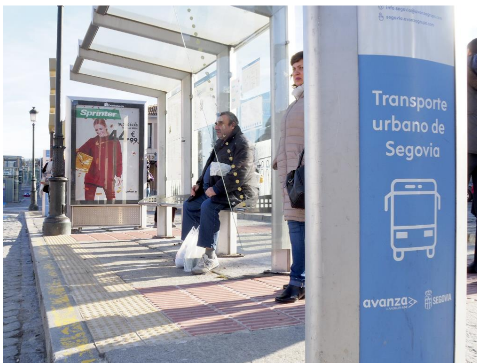
Fig. Ejemplo de colocación de paneles tacto-visuales señalizando una marquesina de espera
