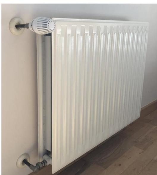
Figura 15: Radiador de chapa de acero.
