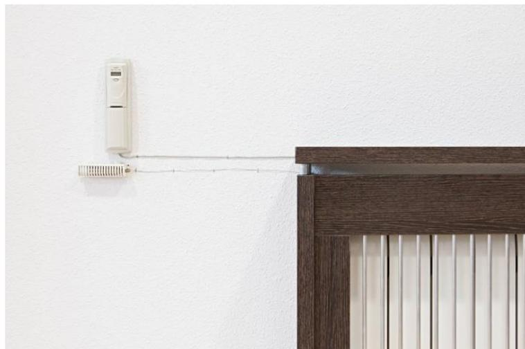
*Figura 08: Repartidor de costes con sensor.
