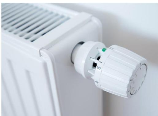
*Figura 05: Válvula termostática.*
