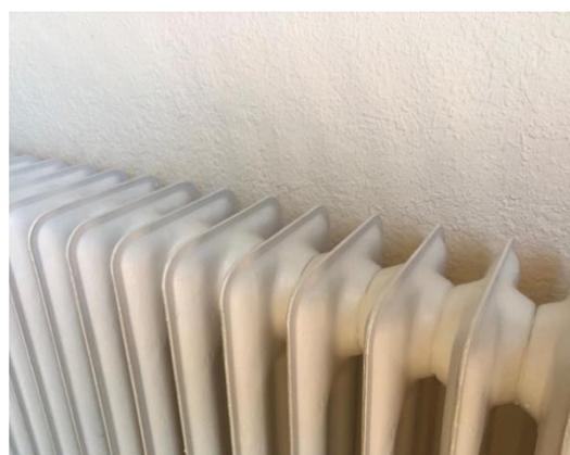
*Figura 12: Detalle radiador hierro fundido.
