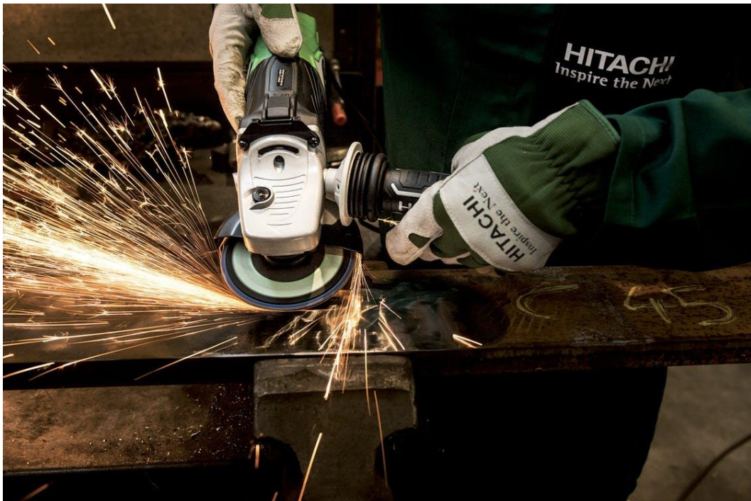
Figura 3: Amoladora trabajando con acero (Imagen de archivo CC0).
