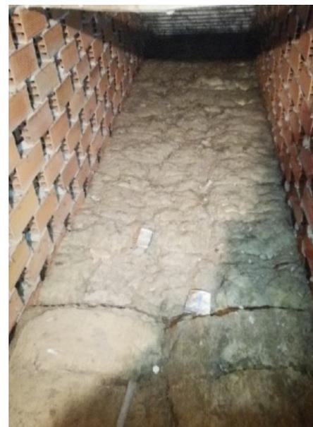
Figura 4. Aislamiento en mal estado en entrecubierta no habitable.
