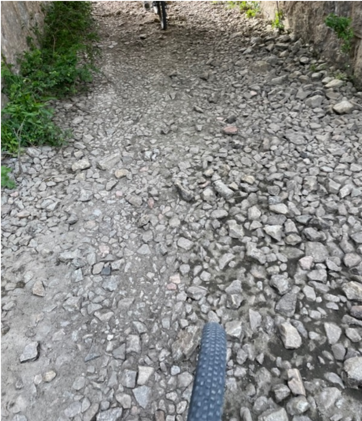
Fotografía 19. Túnel de las vías del tren
