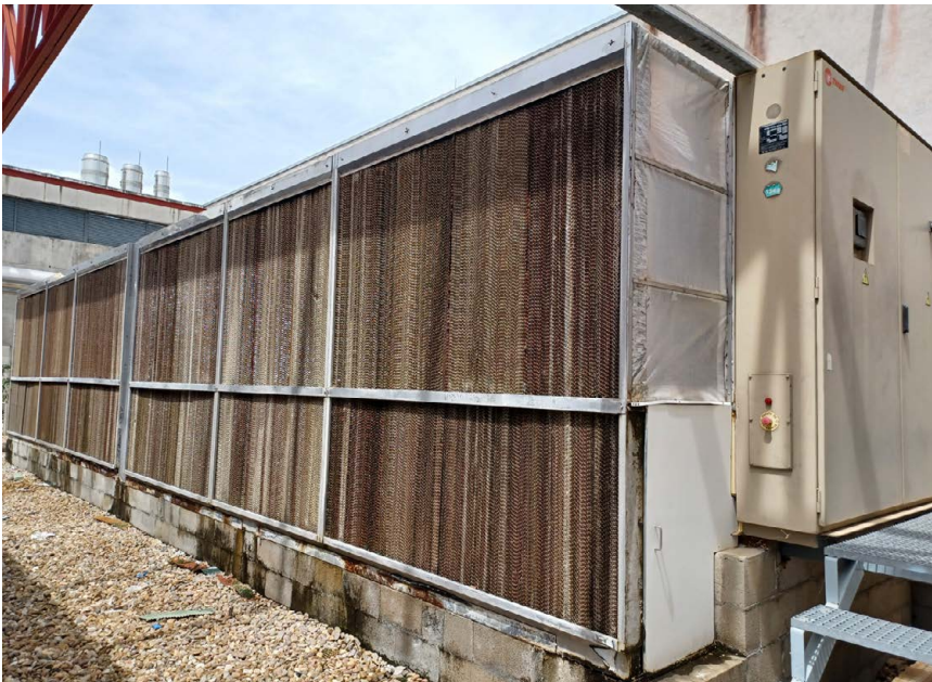
1. Condensadoras por aire 2. Mismos equipos con paneles de preenfriamiento adiabático.
