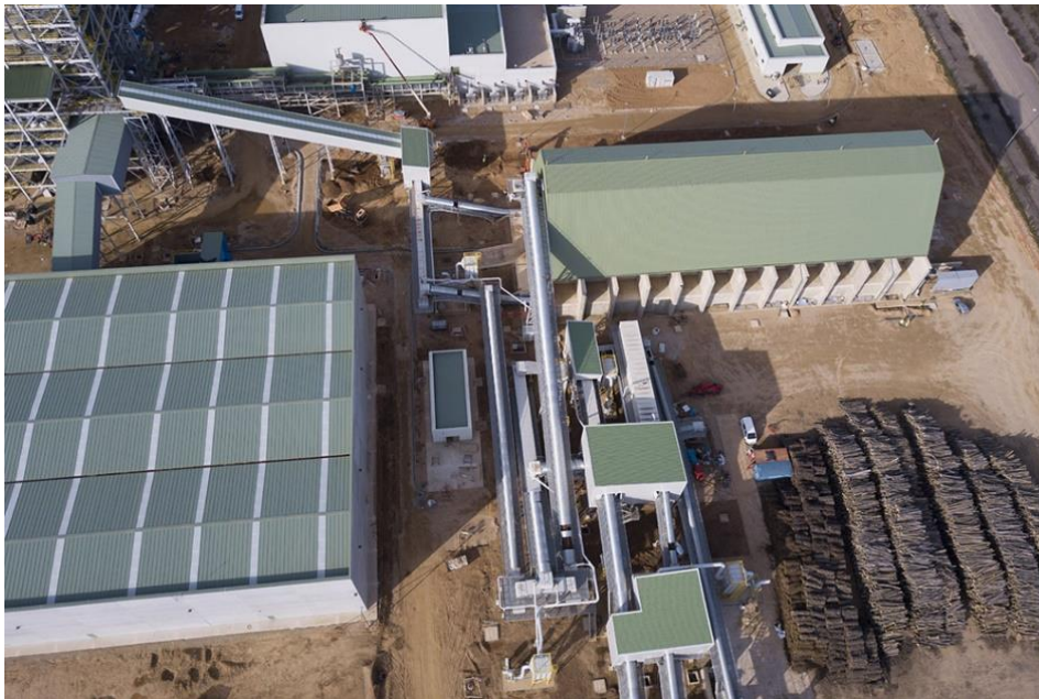
Figura 34. Vista aérea de la zona de almacenamiento de corta duración de biomasa forestal y de los dispositivos de manejo y alimentación de biomasa [31].
