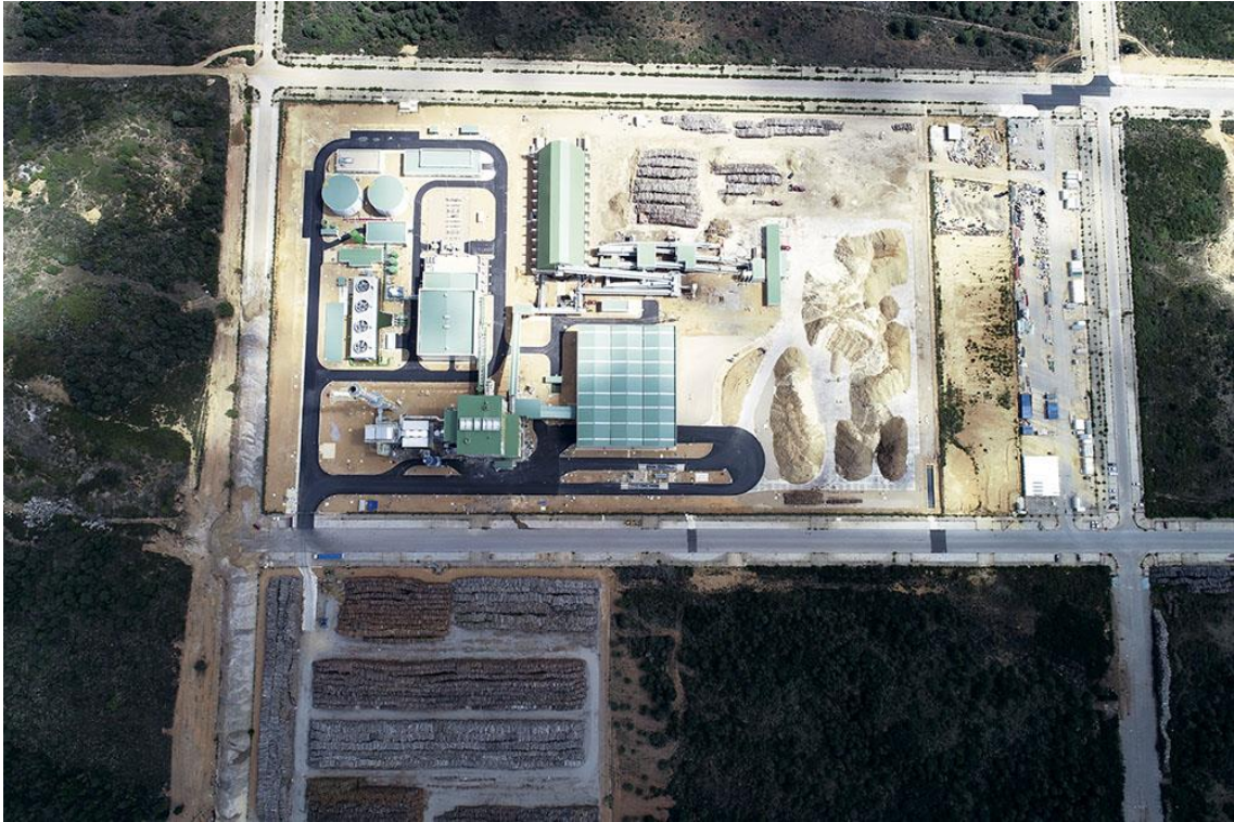
Figura 33. Vista aérea de la disposición de los distintos sistemas de la planta de eléctrica de biomasa de Forestalia en Cubillos de Sil. En la parte inferior de la imagen se ven las pilas de almacenamiento de biomasa de larga duración. [31]
