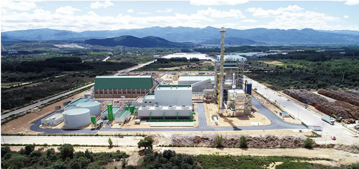
Figura 32. Planta de eléctrica de biomasa de Forestalia en Cubillos de Sil [31]
