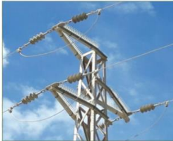
Ilustración 31. Espinas de policarbonato. Fuente: Catálogo EnverTec.
