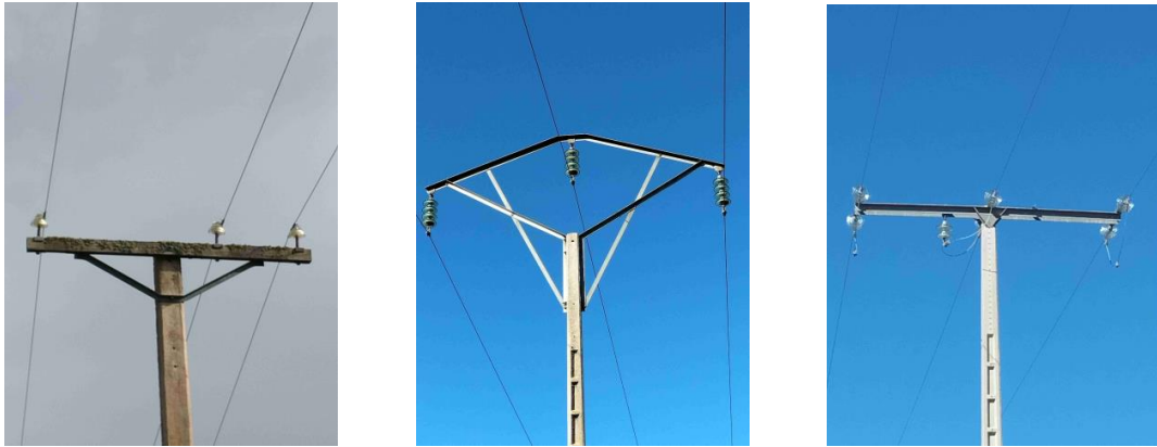
Ilustración 5. Aisladores rígidos, suspensión y amarre de izquierda a derecha.
