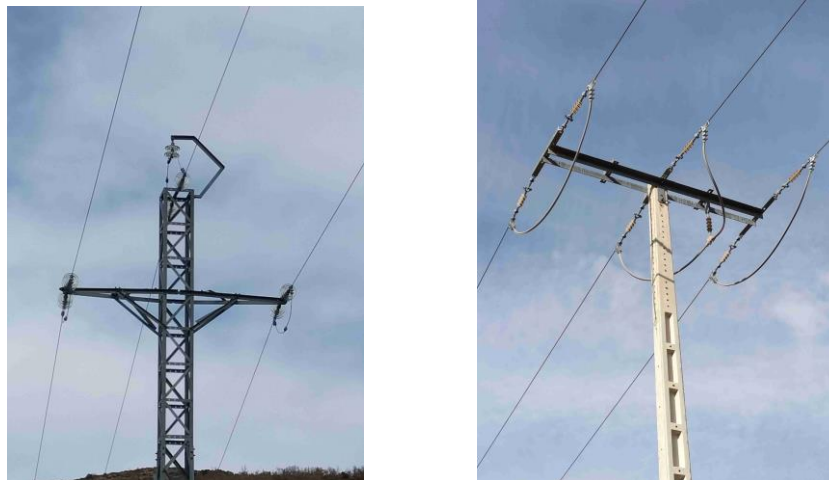
Ilustración 6. Puente central por encima y puentes por debajo de izquierda a derecha.
