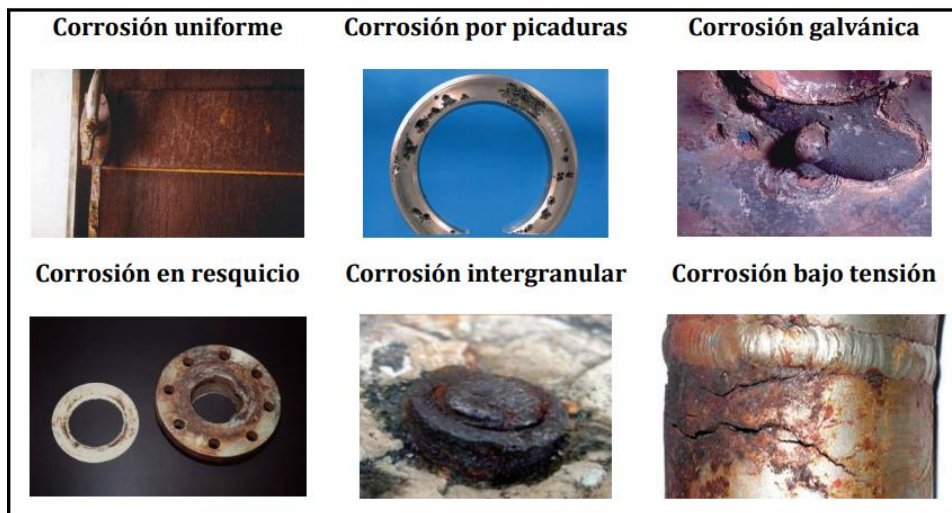
Figura 2.7. Resumen de los tipos de corrosión explicadas anteriormente [15].
