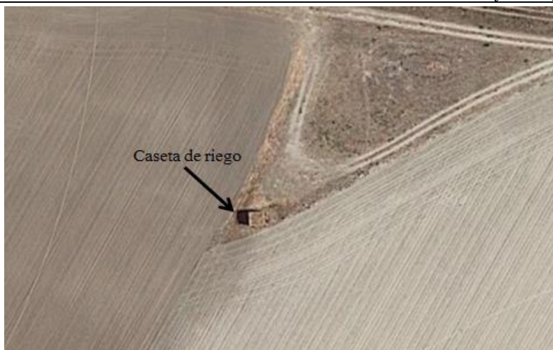
Figura 1. Emplazamiento de la caseta prefabricada de riego.
