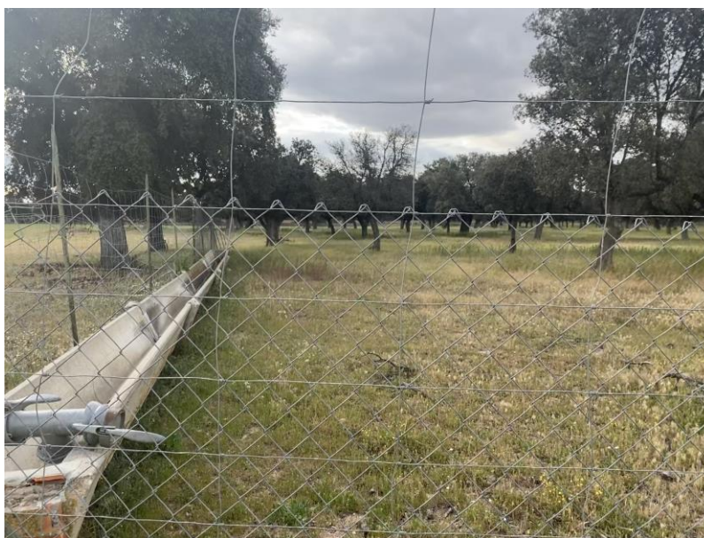
Figura 4. Vista de cerca del tipo de vallado donde se ve la combinación de malla cinérgica con la malla de triple torsión.
