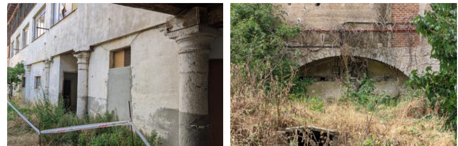
Restos de la tintorería: Columnas y arco.
