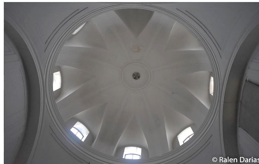
Cúpula en media naranja de la Capilla Mayor con ingresos de luz, fotografía por Ralen Darias, colaborador del MIIA.
