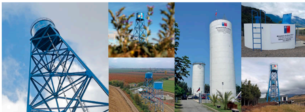
Figura 11. Servicios Sanitarios Rurales. Fuente: Ministerio de Obras Públicas (2020).
