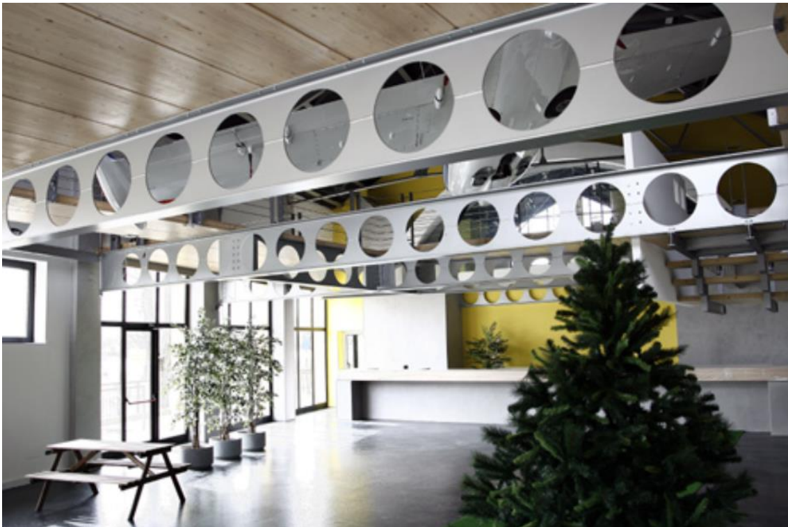
Figura 6. 2 Instalaciones con estructura boyd [2]
