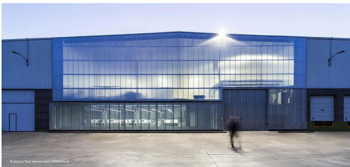
Figura 2. 2 - Nave industrial actual [25]
