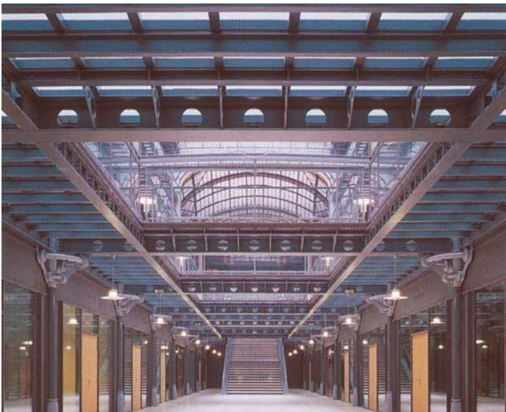
Figura 1. 1 Local con vigas boyd [1]
