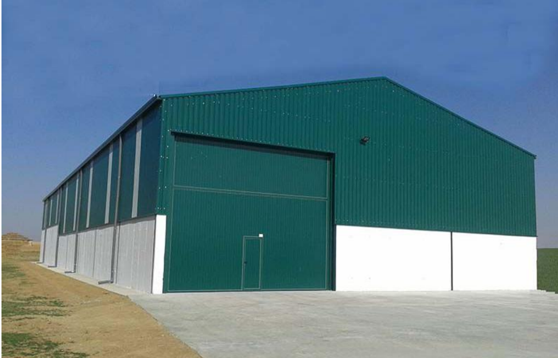
Figura 1. 3 Nave con cerramientos de panel sándwich [18]
