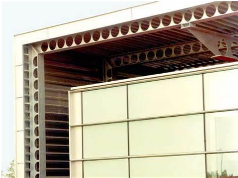
Figura 1. 2 Pórtico con dintel y pilares alveolados [1]
