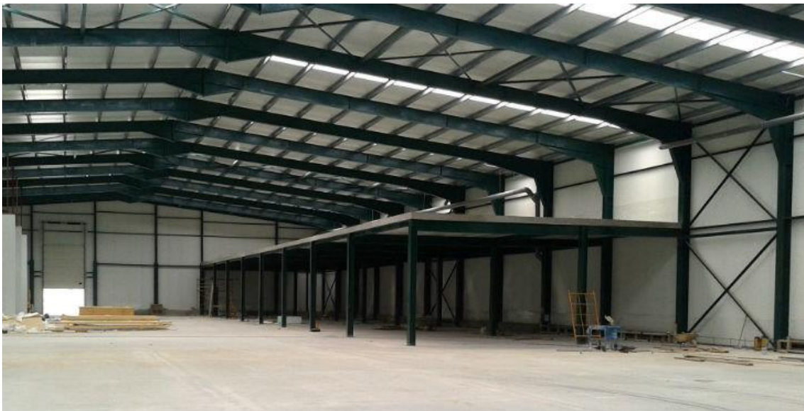
Figura 6. 1 Nave con estructura estándar [14]
