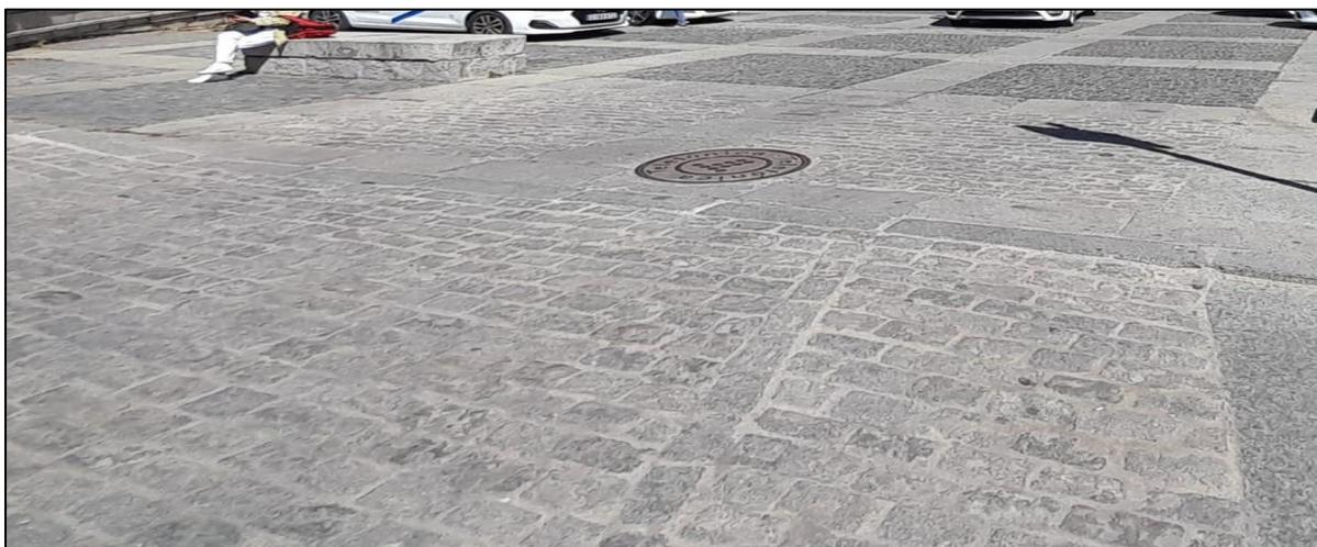
Figura 5.58: Ejemplo de tapa de registro envasada con pavimento en Segovia
