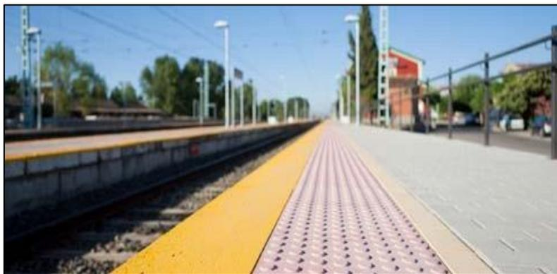
Figura 4.36: Instalación de bandas de proximidad y franjas amarillas en el borde de andén/ Fuente: Adif.es
