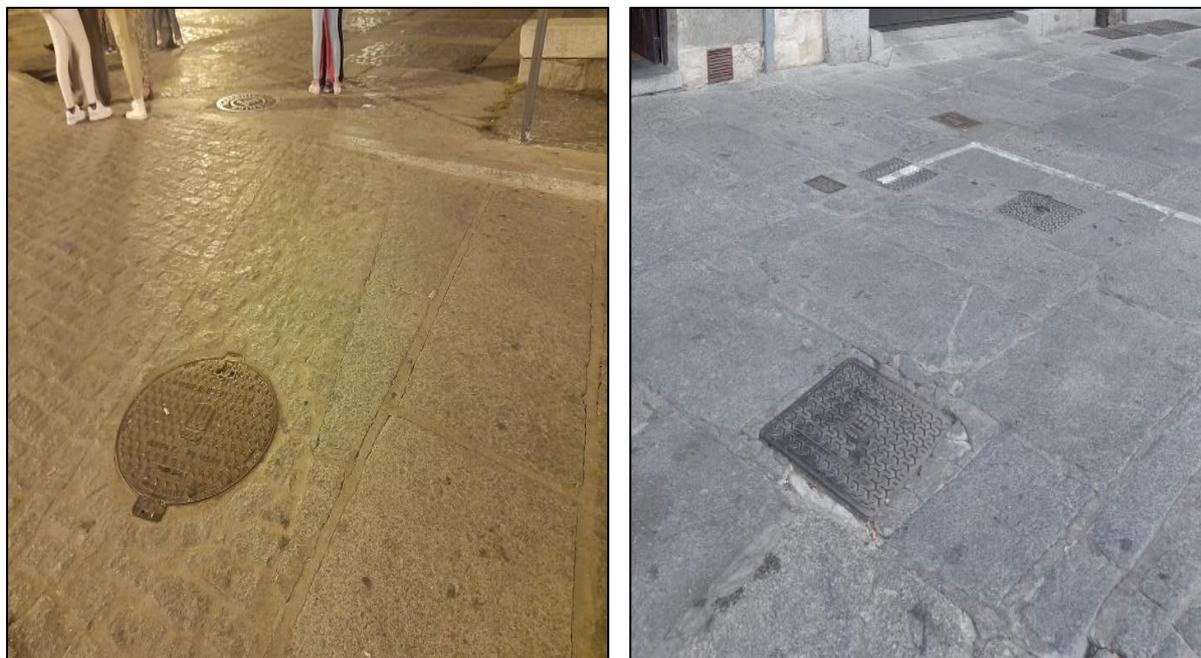
Figura 6.179 y Figura 6.180: Paradas con tapas de registro enrasadas con el pavimento
