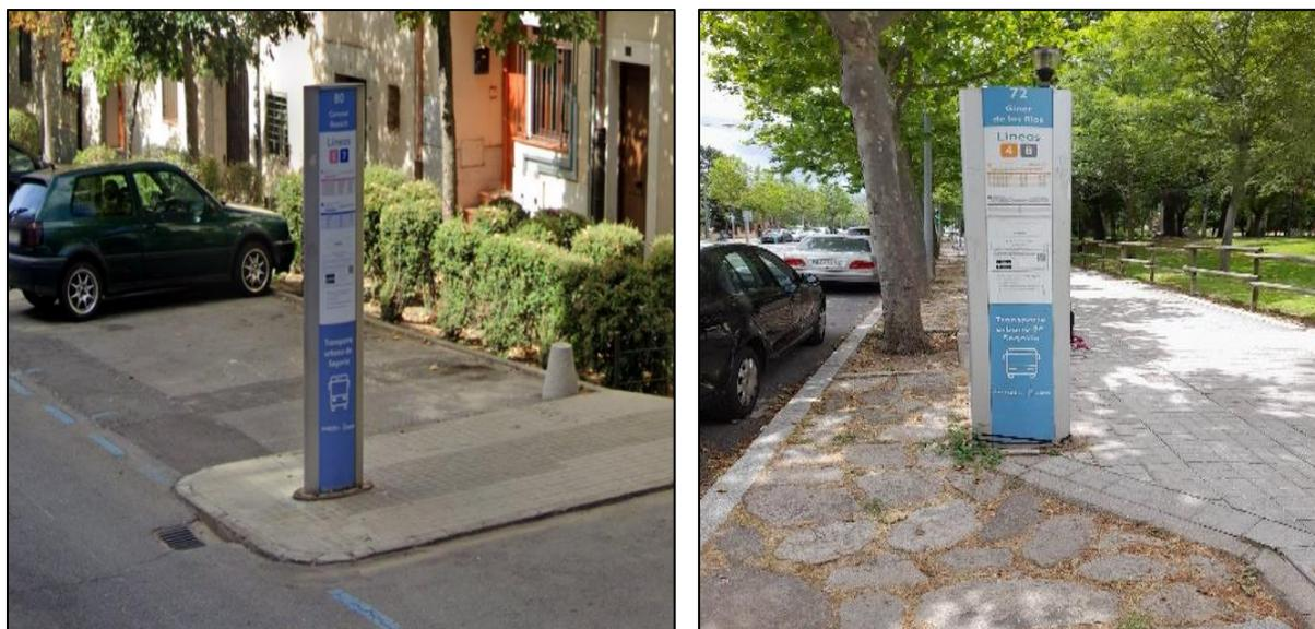
Figura 6.113 y 6.114: Pavimento no continuo y no compacto respectivamente
