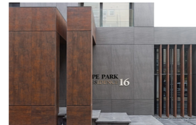
FIG.80_Revestimiento con composite FUENTE_archiproducts.com
