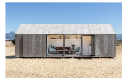
FIG.44_Vista del exterior APH80 FUENTE_plataformaarquitectura.cl
