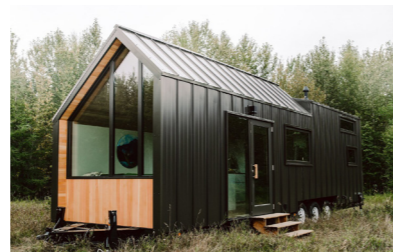
FIG.79_Revestimiento con chapa metálica FUENTE_latinys.com
