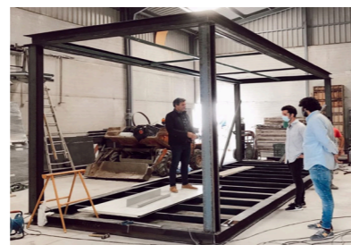
FIG.67_Elaboración de la estructura de acero laminado FUENTE_instagram/tinyhome
