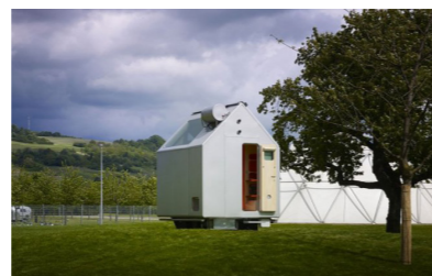
FIG. 18_Vista del exterior FUENTE_tecnne.com
