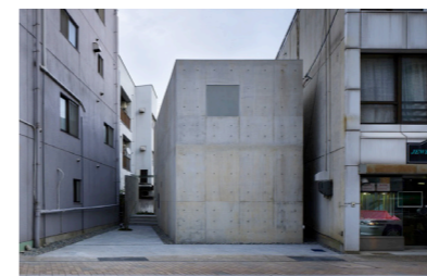
FIG. 22_Casa en Hiro, Tokio, Japón FUENTE_plataformaarquitectura.cl
