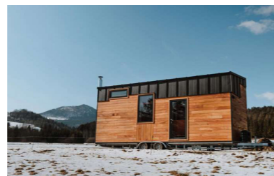
FIG.77_Revestimiento con tableros de madera FUENTE_berghaus-tinyhouse.com
