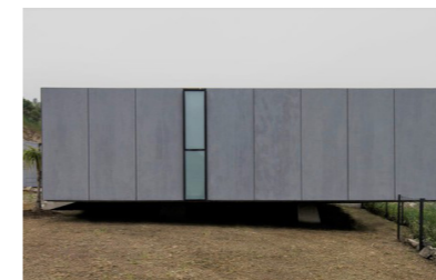
FIG.78_Revestimiento con paneles de fibrocemento FUENTE_tinyhousesbybrady.com
