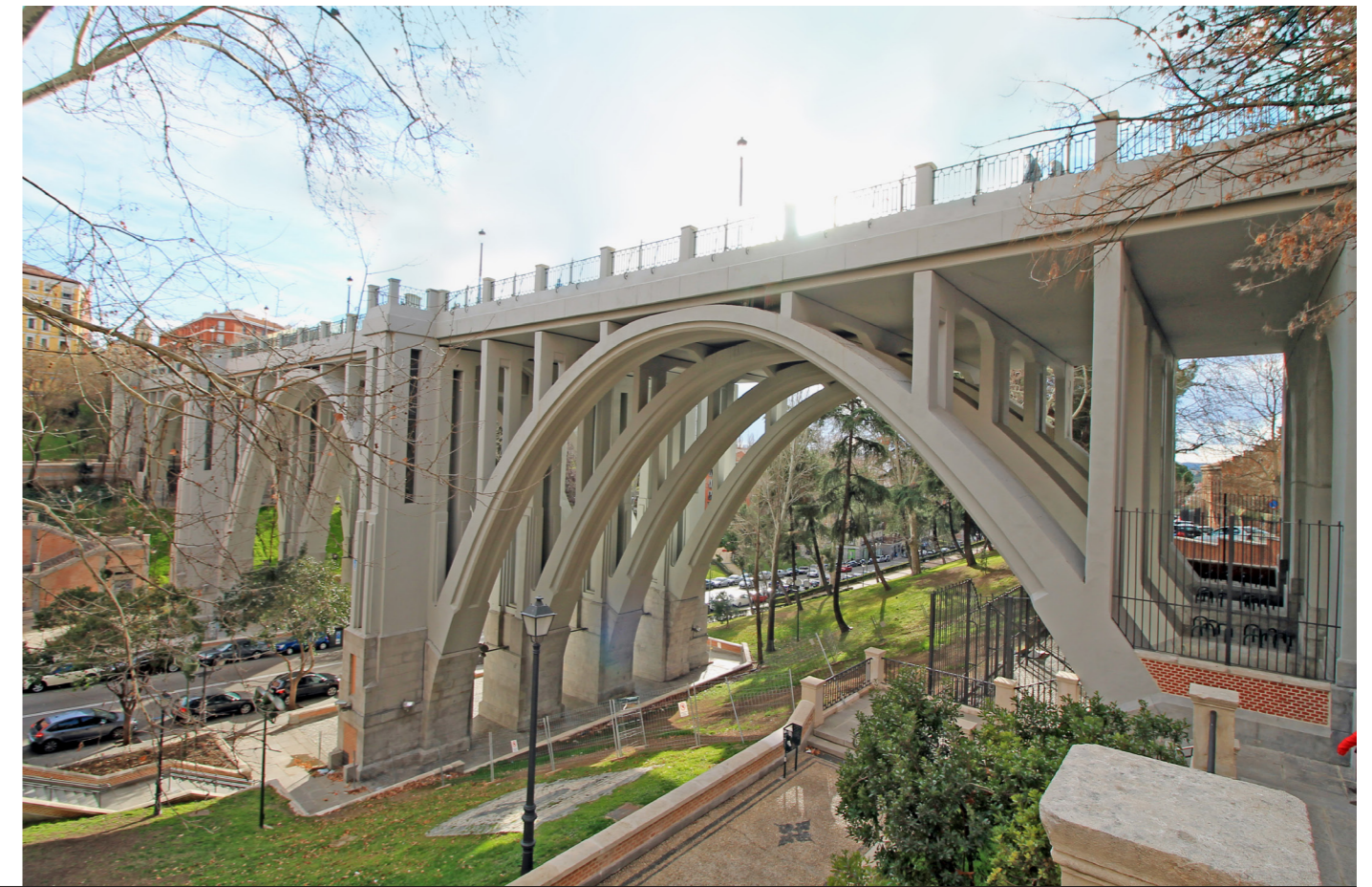
Fig 117. F. J. Ferrero. Viaducto de Segovia.
