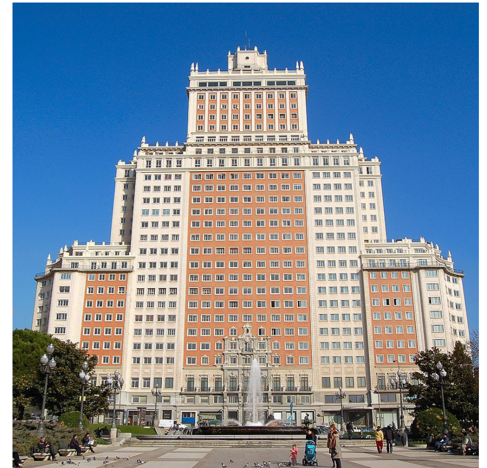
Fig 049. Otamedi. Edificio España. Exterior actual
