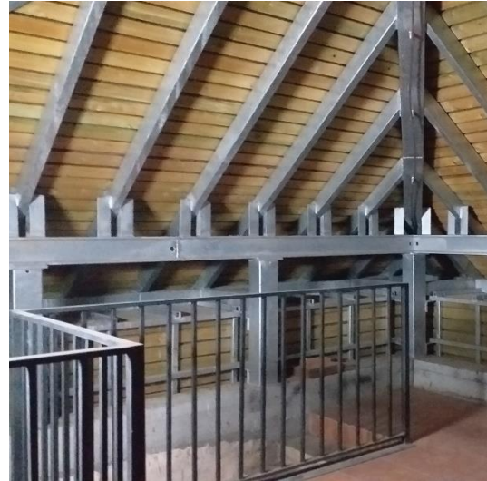
Fig. 52 Interior de la cubierta nueva en 2022. Imagen del autor.
