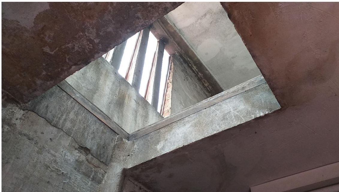
Fig. 61 Complicado acceso a la supuesta sala de campanas desde el cuarto de máquinas. Imagen del autor.
