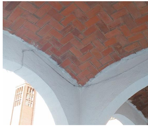
Fig. 29 Detalle de bóveda tabicada de ladrillo visto en los soportales de la plaza. Imagen del autor
