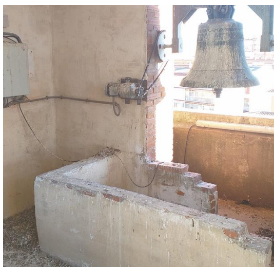
Fig. 22 Interior de la sala de campanas. Llegada de la escalera y abertura con campana para volteo. Imagen del autor.
