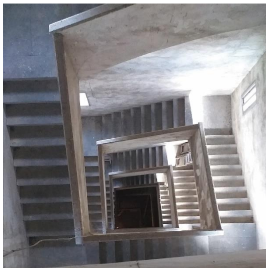
Fig. 46 Escalera de subida a la torre. Imagen del autor.
