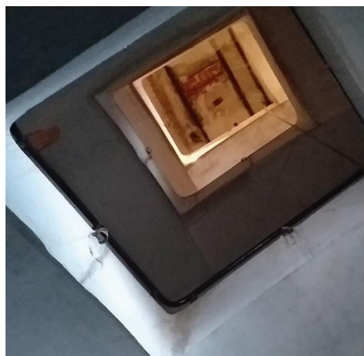
Fig. 23 Vista de escalera interior. En el centro del murete de cada tramo, una guía metálica para la cuerda, que ha dejado marcas de uso sobre el enlucido. Imagen del autor
