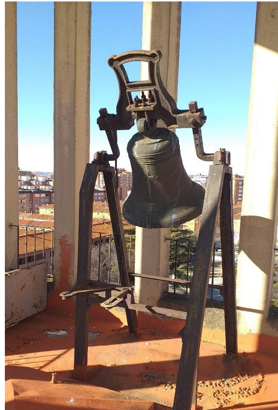
Fig. 34 Campana fundida en 1957 e instalada sobre caballete metálico en la torre de la iglesia de María Reina Inmaculada de Palencia. Imagen del autor
