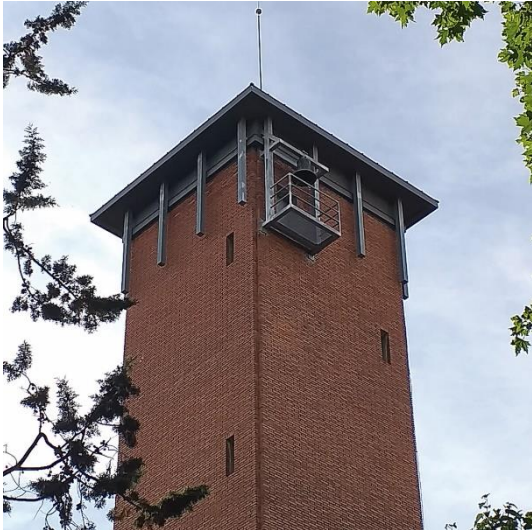
Fig. 51 Remate de la torre en 2022. Imagen del autor.
