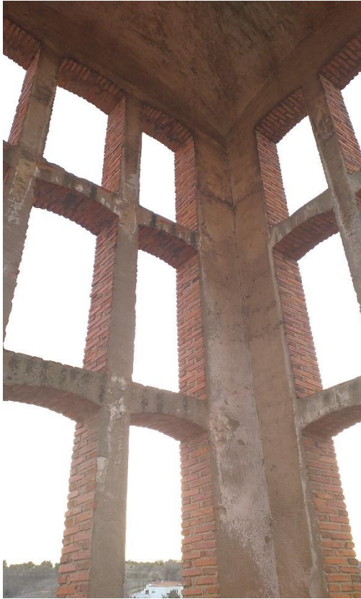
Fig. 33 Vista interior de la sala de campanas. Arriba, la bóveda tabicada que con su curvatura mejoraría la difusión del sonido. Imagen del autor
