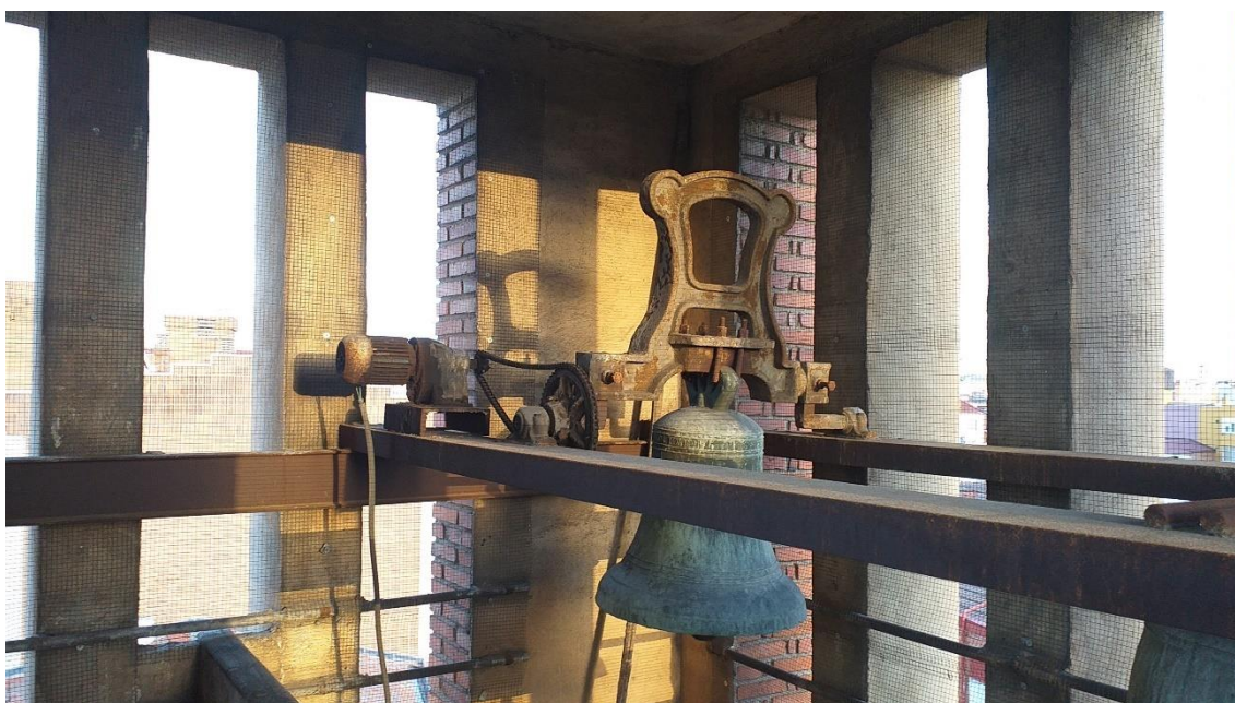
Fig. 55 Interior de la sala de campanas. Instalación de una de ellas. Imagen del autor.
