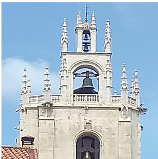
Fig. 15 Espadaña con campanas de señal horaria en la torre de la Catedral de Palencia. Imagen del autor.
