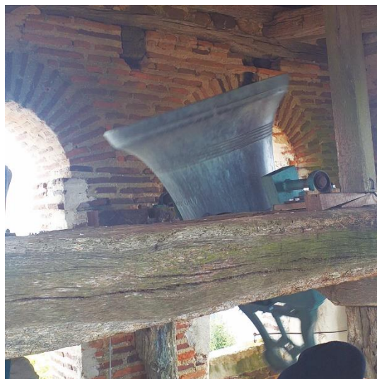
Fig. 14 Campana con ejes apoyados sobre típica subestructura lignaria castellana, en el interior de la sala, durante un volteo en Villota del Páramo. Imagen del autor.
