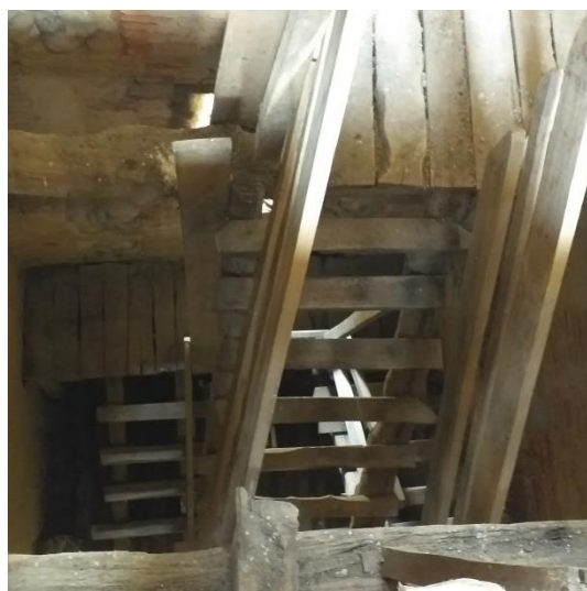
Fig. 16 Escalera y plataformas interiores de madera en Villota del Páramo. Imagen del autor
