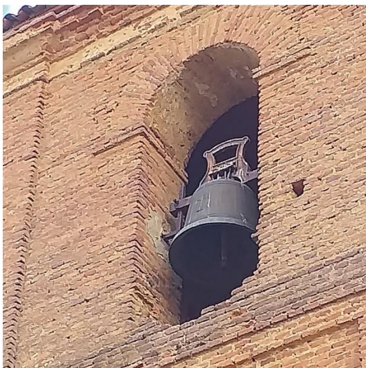
Fig. 13 Campana colgada en el vano, con ejes apoyados en la cara interior de las jambas. Iglesia de Quintanilla de la Cueva. Imagen del autor.
