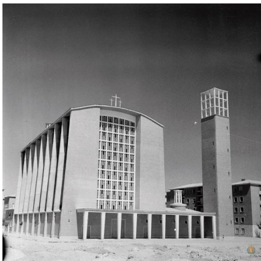
Fig. 45. Vista general de la iglesia poco después de su finalización. Fuente: arquitecturava.es , y éste de Archivo Carvajal (años 70).
