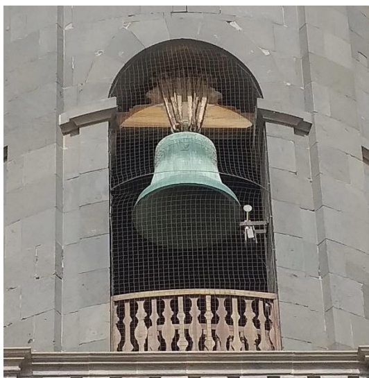
Fig. 5 Campana fija percutida por un martillo exterior en la Catedral de Las Palmas Imagen del autor
