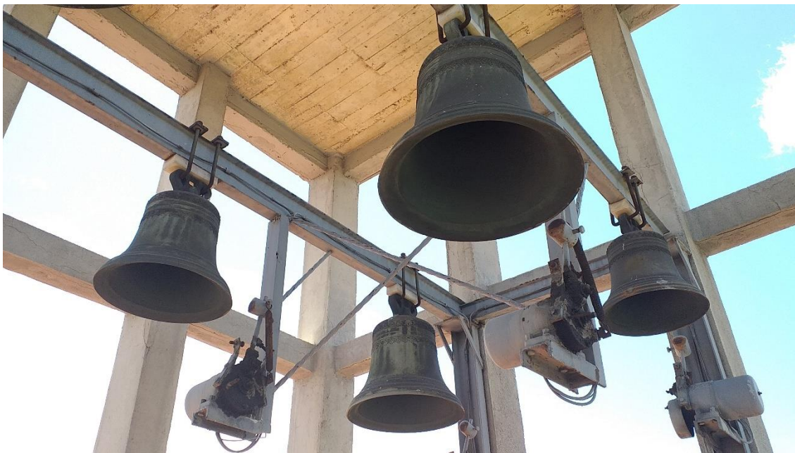
Fig. 44 Instalación de campanas fijas en subestructura metálica. Imagen del autor.
