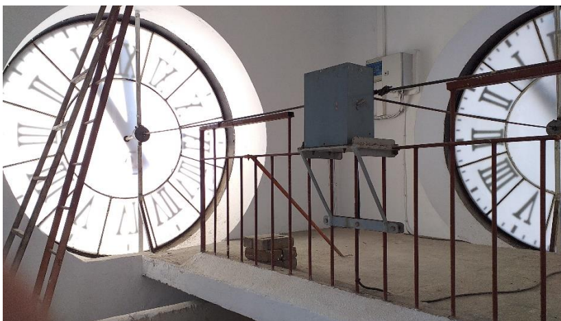
Fig. 42 2 Sala del reloj, plataforma, mecanismo eléctrico y escalera de subida al cuerpo de campanas. Imagen del autor.
