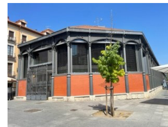
Mercado del Val, Valladolid Fuente: Elaboración Propia
