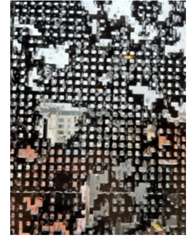
Chapa de la fachada del CAIXAFORUM Fuente: Elaboración propia
