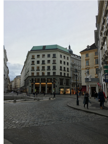
Edificio Goldman y Salatsch Fuente: Elaboración propia
