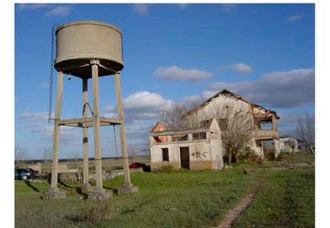
Depósito de agua
