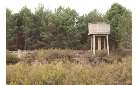
Depósito de agua
