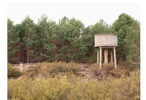
Depósito de agua
