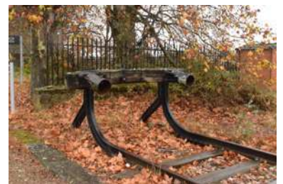
Final de la vía de apartadero de la estación de Sarracín (Imagen propia, 2022).
