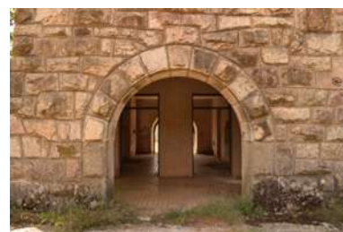
Detalle arco y fachada de piedra del edificio de viajeros de la estación de Abejera (Imagen propia, 2022).
