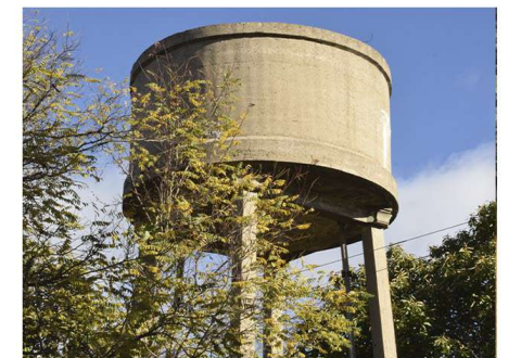
Depósito de agua
