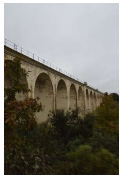
Detalle del viaducto del Vertillo desde la carretera (Imagen propia, 2022).
