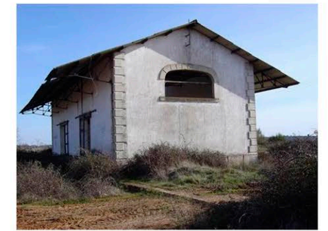
Muelle de carga cubierto, aguada y grúa
