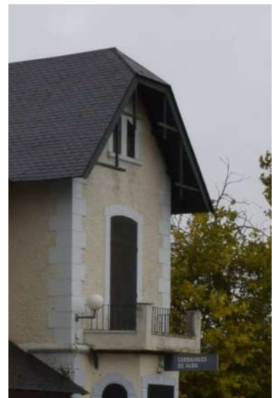
Detalle de los hastiales de la cubierta del edificio de viajeros de Carbajales de Alba (Imagen propia, 2021).
