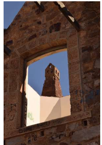
Detalle del remate de las chimeneas del edificio de viajeros de la estación de Pobladura-Las Torres (Imagen propia, 2022).
