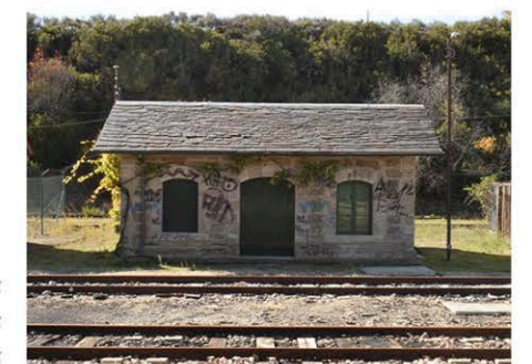
Viviendas auxiliares interiores
