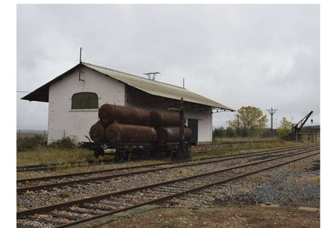
Muelle de carga cubierto, aguada y grúa
