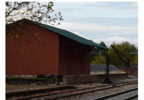
Muelle de carga cubierto (con grúas de agua y dinámica)
