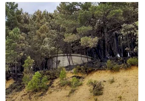
Depósito de agua
