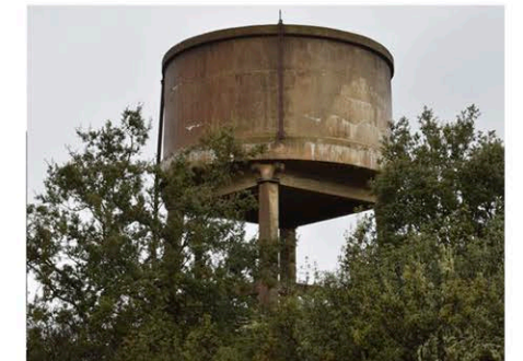
Depósito de agua
