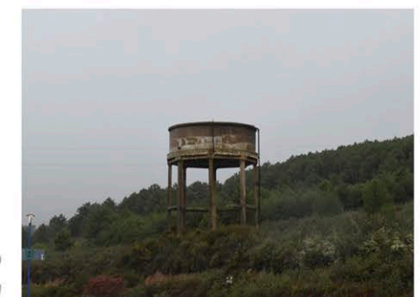
Depósito de agua
