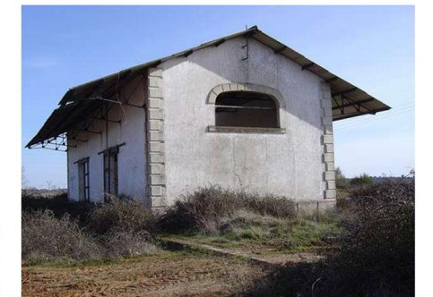
Muelle de carga cubierto, aguada y grúa
