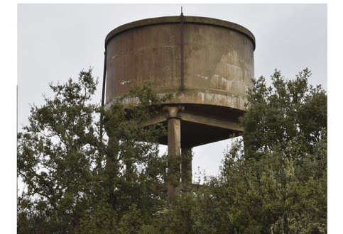
Depósito de agua
