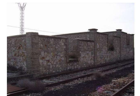
Muelle de carga de gando
