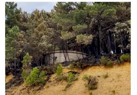
Depósito de agua
