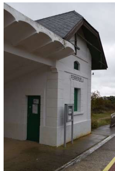
Detalle del remate de la cubierta del apeadero de Ferrerueta (Imagen propia, 2022).
