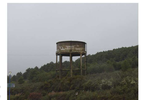
Depósito de agua
