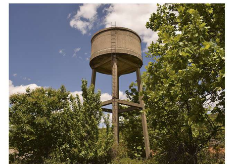
Depósito de agua
