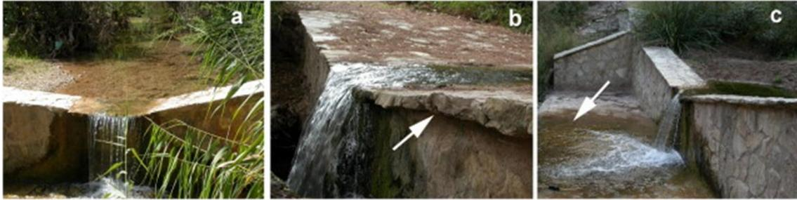
Figura 7. Detalles de la presa diseñados para minimizar el riesgo de dispersión río arriba de cangrejos de río invasores: techo en forma de V (a), borde saliente (flecha blanca) (b) y piso pedregoso plano aguas abajo de la presa (c). Fuente: Elías D. Dana y Juan García de Lomas (2011).
