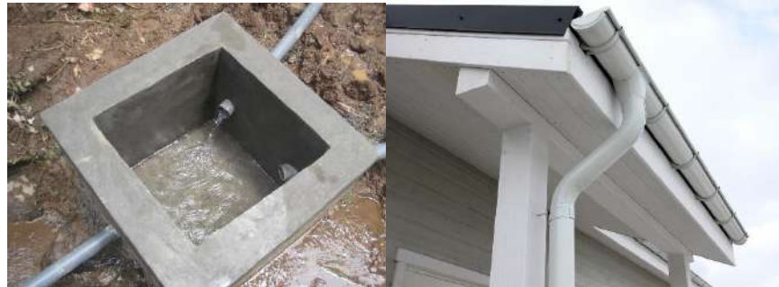
Ilustración 1. Red de evacuación de aguas pluviales.
