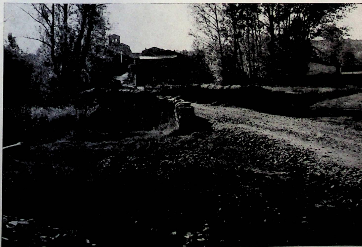
1. Vista del puente de Golmayo aguas arriba del río.—2. Vista del mismo aguas abajo.
