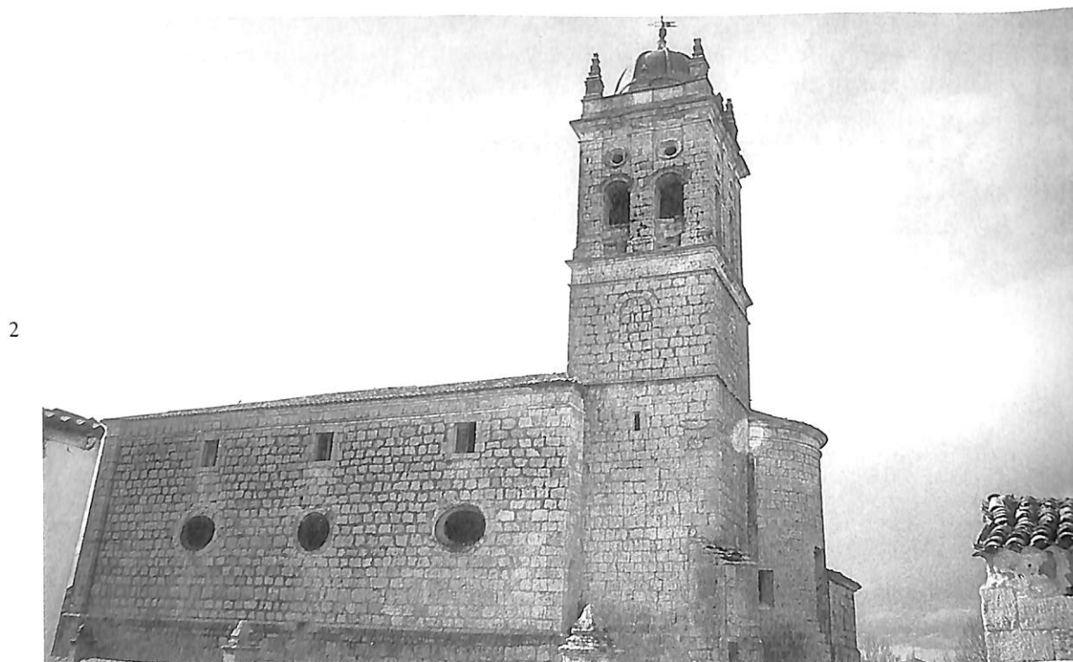
Ibero del Castillo (Burgos). Iglesia parroquial. 1. Fachada principal.—2. Torre.
