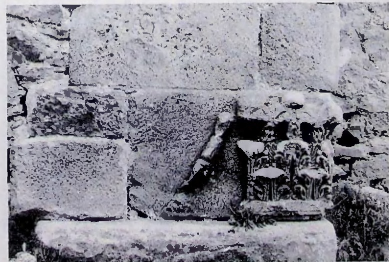
1. Varios elementos arquitectónicos reaprovechados en la Iglesia de Ventosilla.—2. Friso conservado en la torre de la Iglesia de Renieblas.—3. Detalle del bloque capitel-antorcha de Ventosilla.
