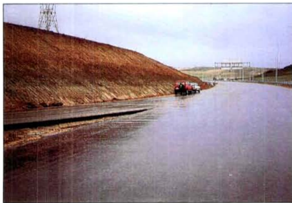
En la fase de construcción se deberían empezar los labores de revegetación para evitar la erosión de los taludes. N-620 (Circunvalación Valladolid).
